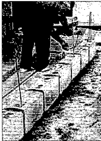
FOTO N°23 El refuerzo vertical (dowels) debe encajar perfectamente en los alvéolos
