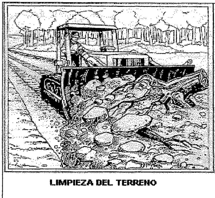
Perfilar el terreno para un adecuado drenaje (% de bombeo) y nivelar la superficie, para dejarla exenta de escombros, luego se compacta con el equipo apropiado la superficie del terreno de fundación. Es necesario tener en cuenta la excavación para la conformación de cunetas, en la cual se puede utilizar una motoniveladora
