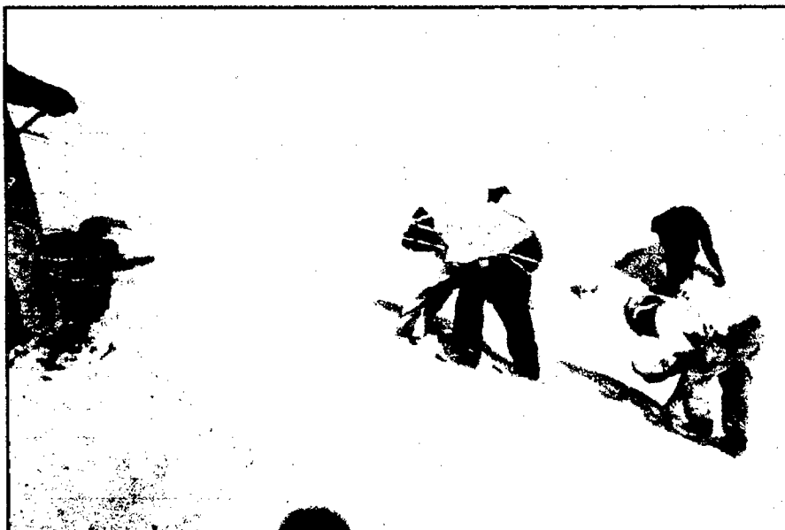
II.9.9: Sellado de las juntas longitudinales y transversales del canal trapecial con DYNATRED.
