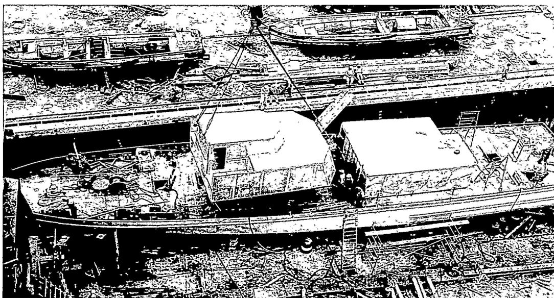
Fotografía N° 8.- Construcción de Patrullera de Costa B.A.P. "RIO CHIRA" en las instalaciones del SIMA CALLAO 1970
