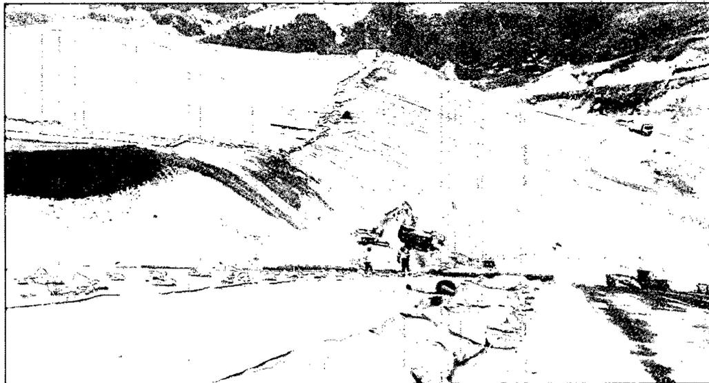
Figura 1.3 Conformación del suelo de baja permeabilidad e instalación de la geomembrana, como parte del sistema de revestimiento de una pila de lixiviación.
