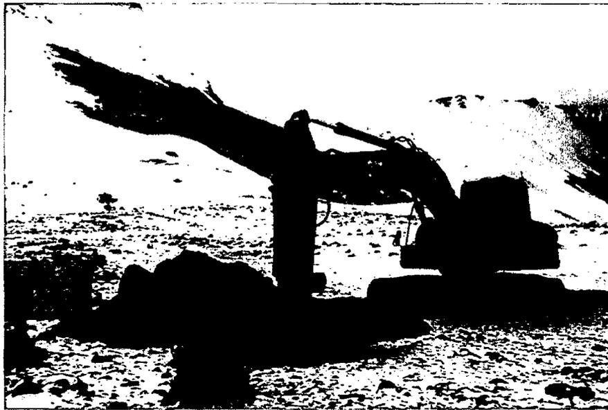
Figura 3.1 Excavación con maquinaria de una calicata.
