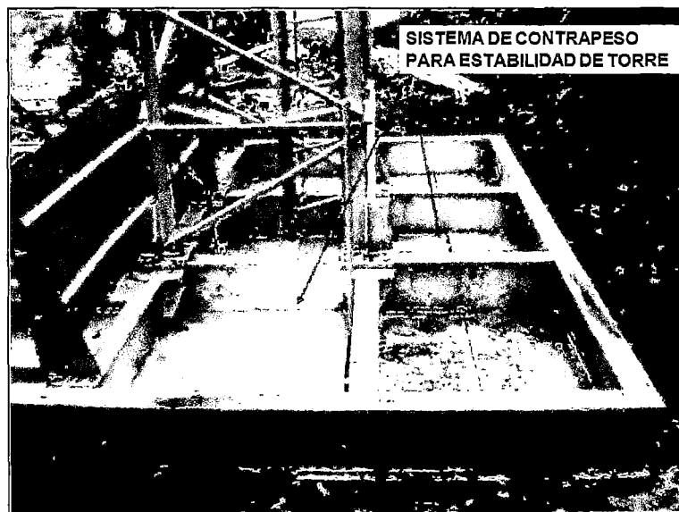
Figura 5.8: Sistema de contrapeso para estabilidad de torre de la Estación.
