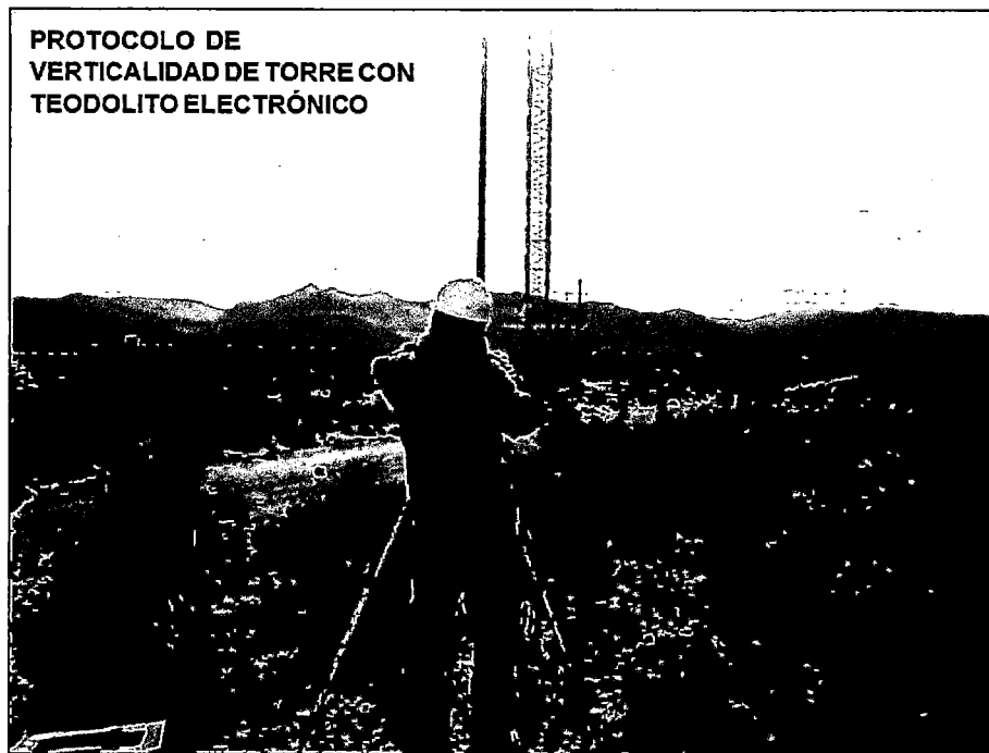
Figura 5.12: Mediciones de verticalidad de torre.
