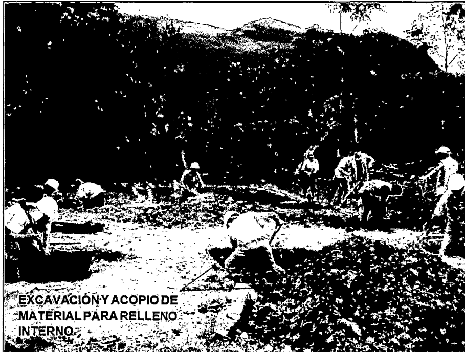
Figura 5.5: Excavación para zapatas metálicas y acopio de material para relleno.
