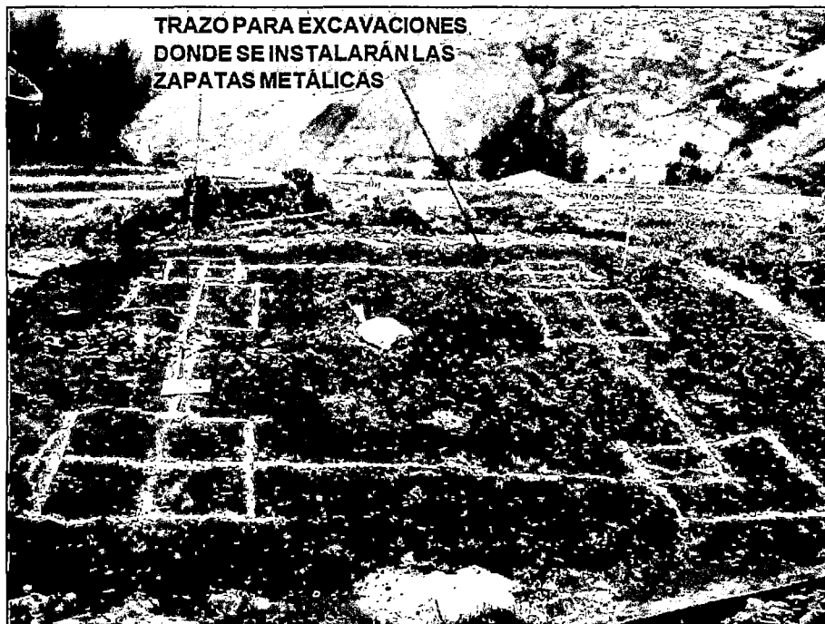
Figura 5.4: Trazo y replanteo para excavaciones.
