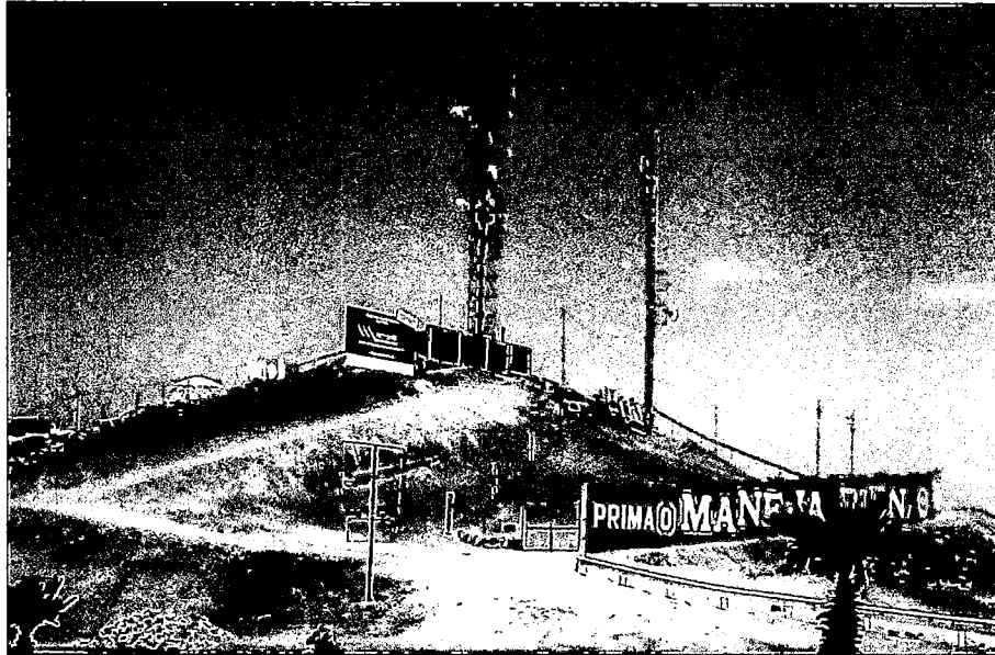
Figura 3.5: Estación base celular tradicional con una torre auto soportada de celosía de una altura de 30 m.
