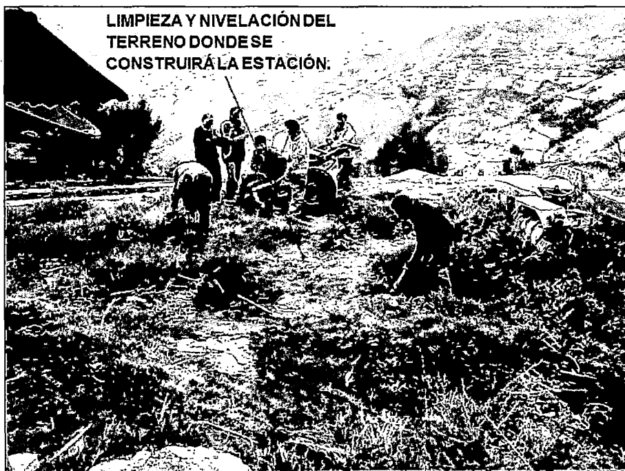
Figura 5.3: Limpieza y nivelación del terreno donde se construirá la Estación.
