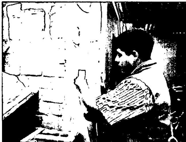
**Foto 5:** Medición de Refuerzo longitudinal en Columna 1 del Segundo Nivel
