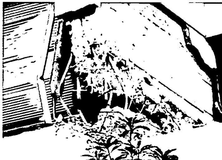
**Figura 4.5 (c): Fallas por corte en Placa**
