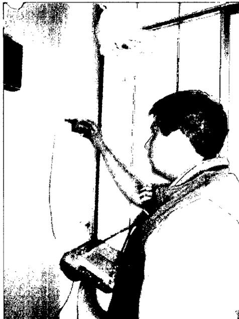
**Foto 8:** Medición de Refuerzo transversal en Columna 3 del Primer Nivel
