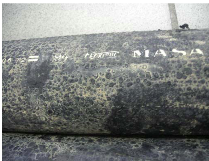
FIGURA 29. DECAPADO EXTERIOR EN UNA TUBERÍA DE LDPE
