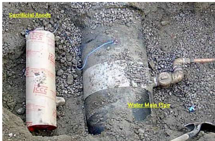
FIGURA 17. INSTALACIÓN DE UN ÁNODO DE SACRIFICIO EN UNA TUBERÍA METÁLICA
