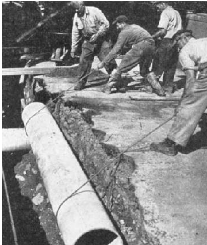
FIGURA 12 INSTALACIÓN DE TUBERÍA DE FIBROCEMENTO, AÑO 1953
