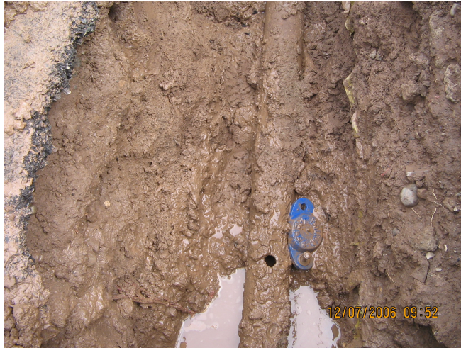
FIGURA 60. CONEXIÓN CLANDESTINA DETECTADA EN LIMA NORTE I
