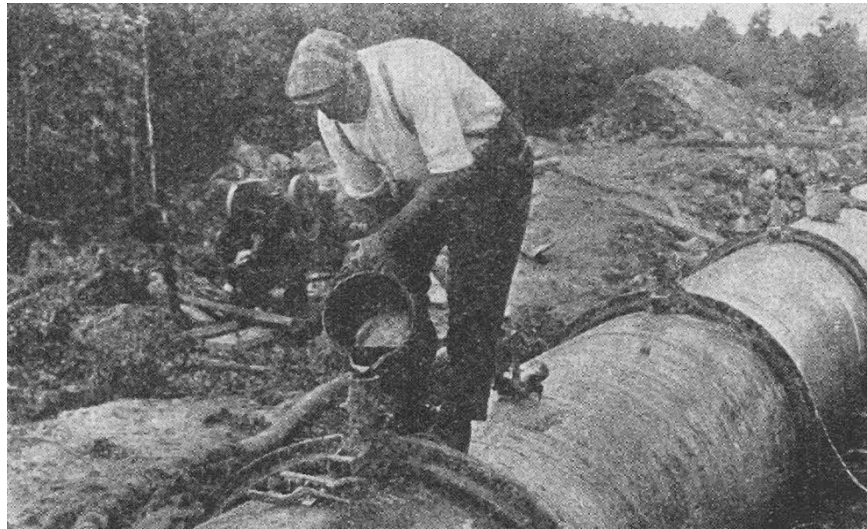
FIGURA 13. TUBERÍA DE FUNDICIÓN GRIS REVESTIDA CON PLOMO
