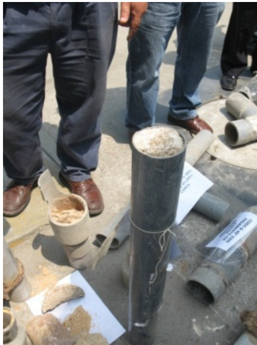
FIGURA 66. OBSTRUCCIÓN TOTAL DE TUBERÍA DE PVC DEBIDO AL CONTENIDO DE CARBONATOS EN EL AGUA SUBTERRÁNEA
