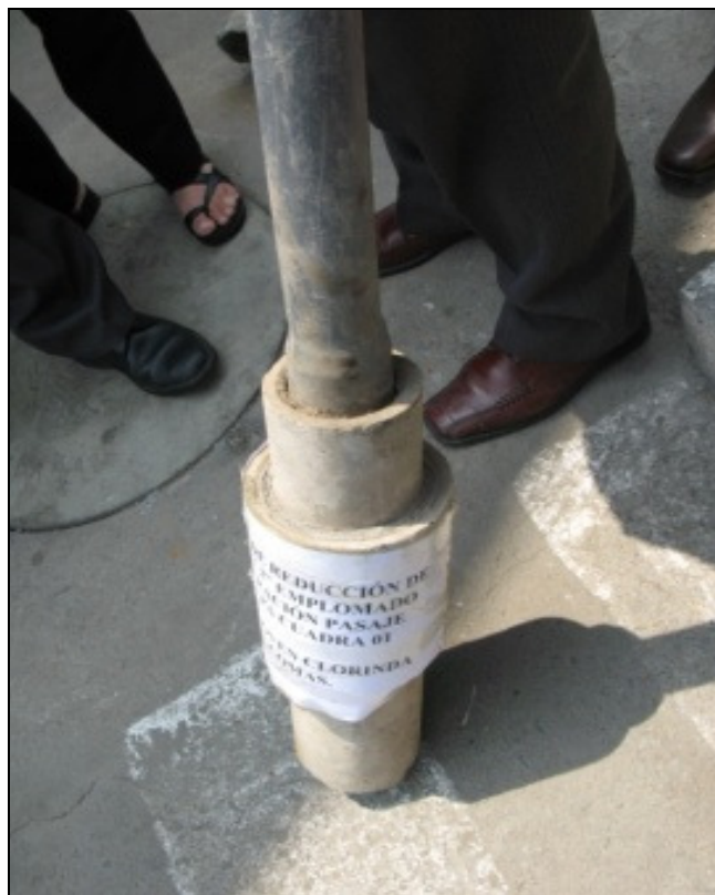
FIGURA 64. REDUCCIÓN CON PLOMO DE AC A PVC
