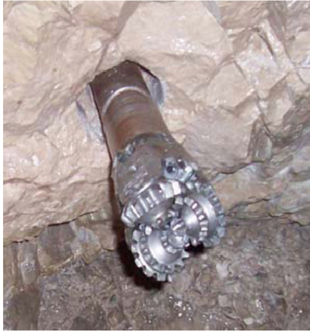
FIGURA G.40. CABEZAL UTILIZADO PARA LA EXCAVACIÓN EN ROCA
