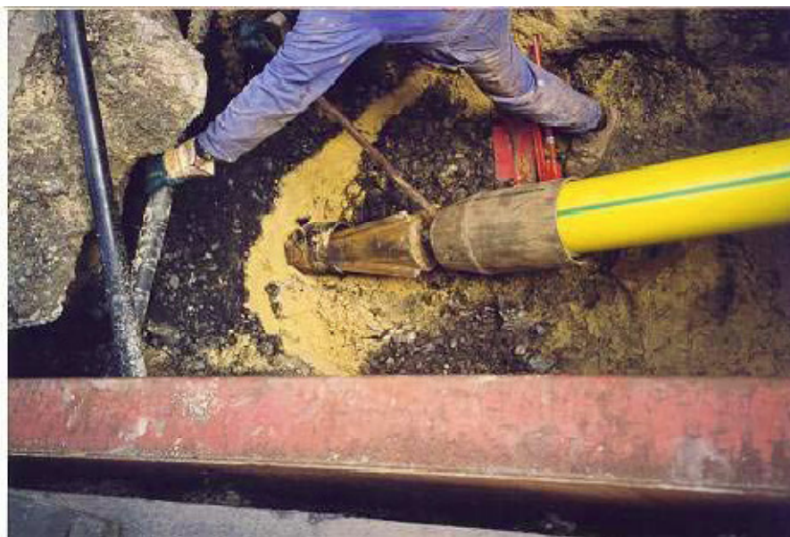
FIGURA G.33. UNIÓN DEL CABEZAL DE TIRO Y LA PIEZA UTILIZADA PARA EL ENSANCHAMIENTO
