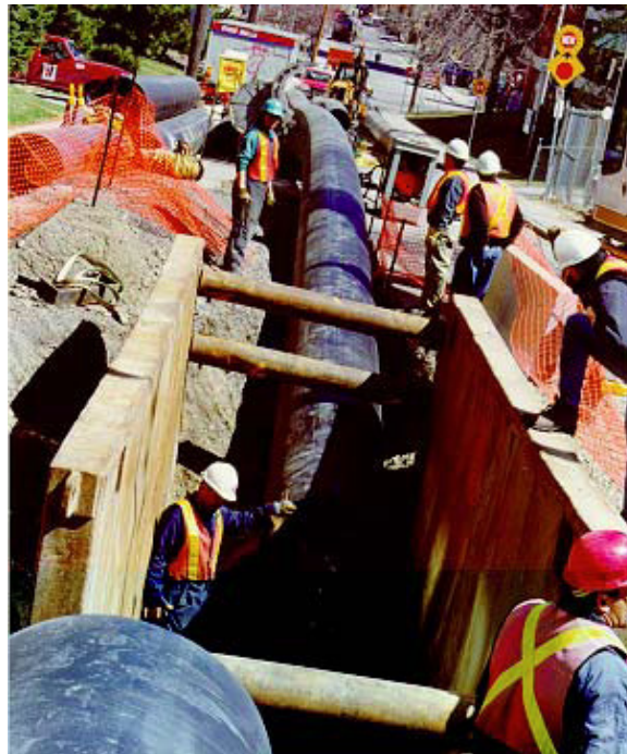
FIGURA G.20. CATA DE ENTRADA EN UNA RENOVACIÓN EN TUBERÍA DE 910 MM DE F°F° MEDIANTE ENTUBADO POR DESLIZAMIENTO CON TUBERÍA DE POLIETILENO DE 840 MM, OTTAWA, CANADÁ
