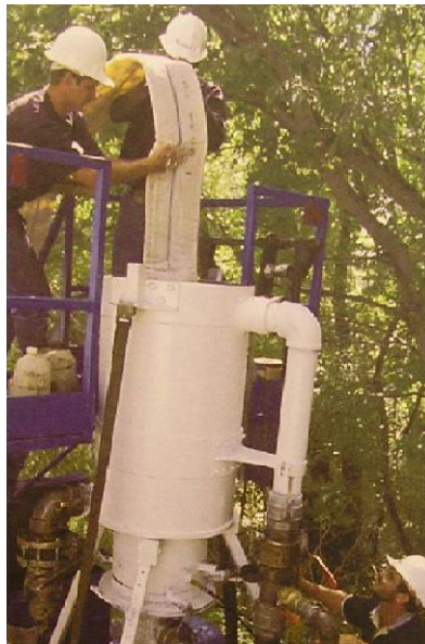
FIGURA G.25. INSTALACIÓN DE MANGA INVERTIDA PARA REHABILITACIÓN
