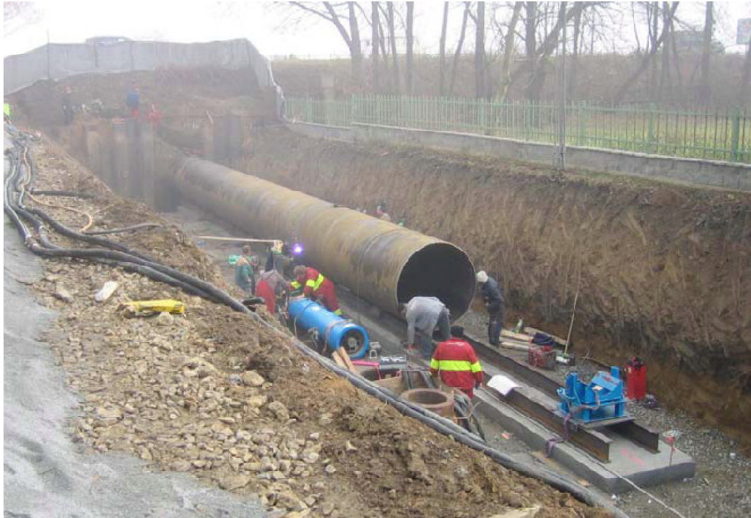
FIGURA G.46. HINCA DE TUBERÍA DE ACERO DE 1800 MM QUE CRUZA UNA AUTOPISTA.
