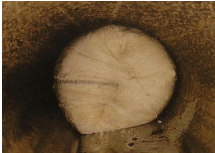
FIGURA G.26. PROCESO DE REVERSIÓN DE MANGA SOBRE ANTIGUA CONDUCCIÓN
