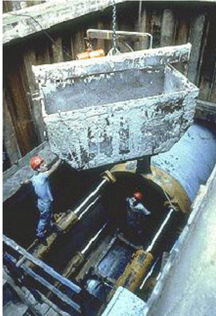
FIGURA G.49. DISPOSITIVOS HIDRÁULICOS DE PERFORACIÓN
