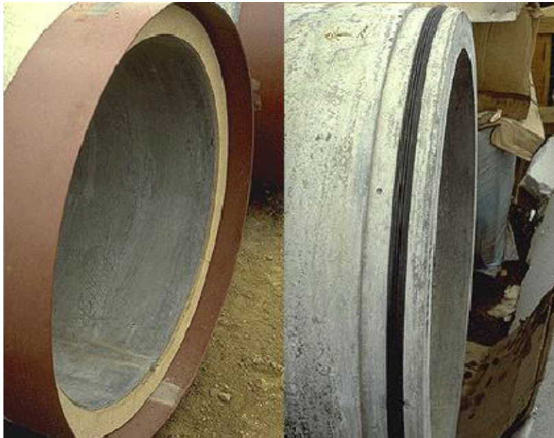
FIGURA G. 50. TUBERÍAS MACHO Y HEMBRA UTILIZADAS EN LAS HINCAS.
