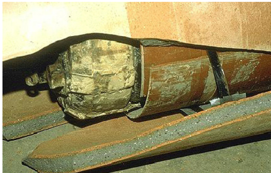
FIGURA G.36. CABEZAL DE TIRO QUE PRODUCE UNA ROTURA EN LA TUBERÍA MEDIANTE PERCUSIÓN NEUMÁTICA.
