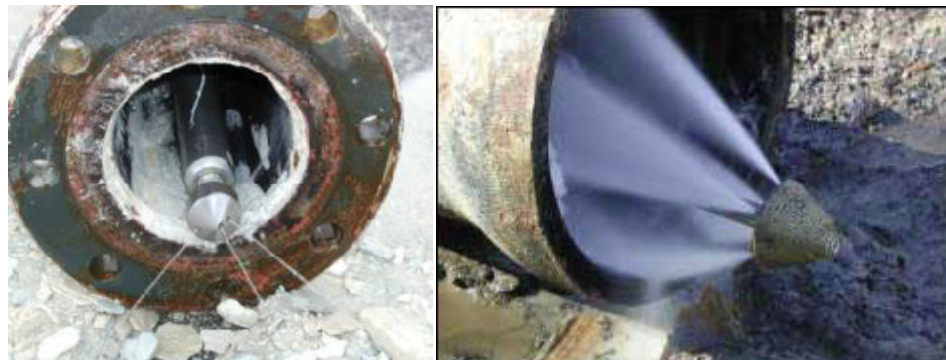
FIGURA G.15. INYECCIÓN DE AGUA A ALTA PRESIÓN.
