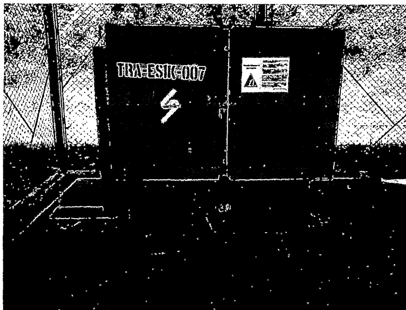
Figura 2.19 Transformador elevador (SUT) Fuente: Pluspetrol
