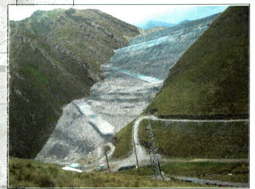
VISTA PANORÁMICA DEL ESPALDÓN DE LA PRESA DE RELAVES
