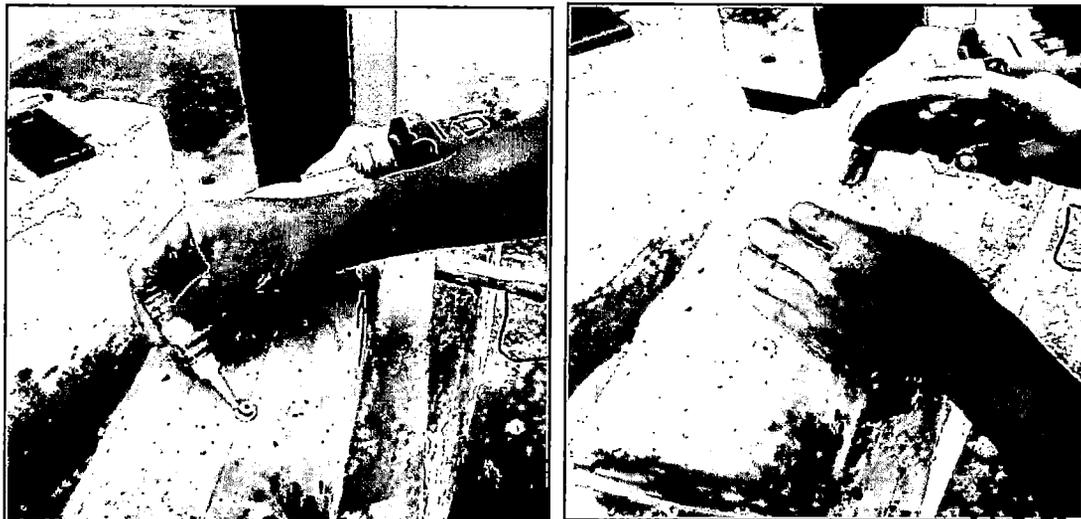
Fig. 3.8: Pernos embebidos en el concreto usando una goma y martillo.
