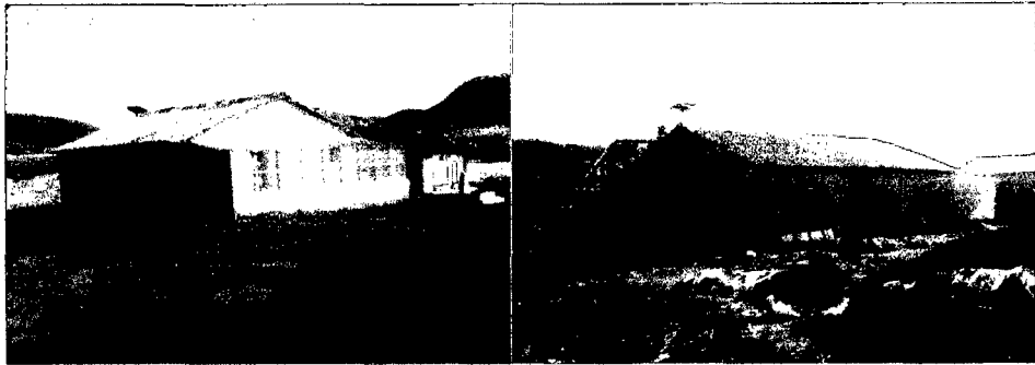
Figura 14 techado final con paja y techado total calamina
