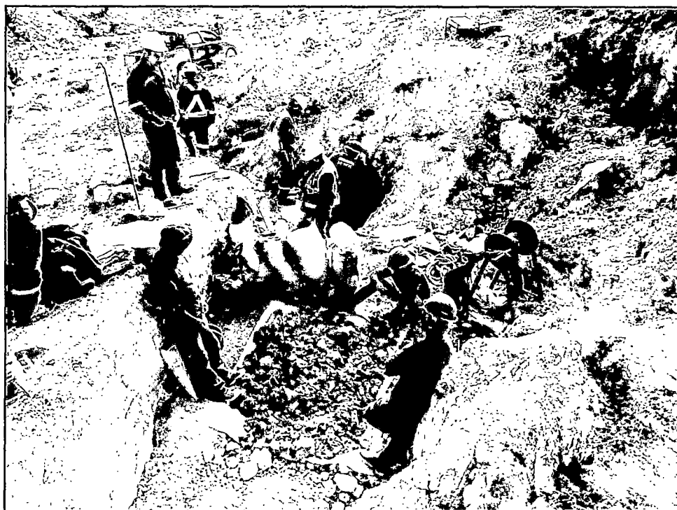
Figura 8. Trabajadores informales trabajando en la Zona de Tessie, a unos 7 km al Oeste de la Unidad Minera.
