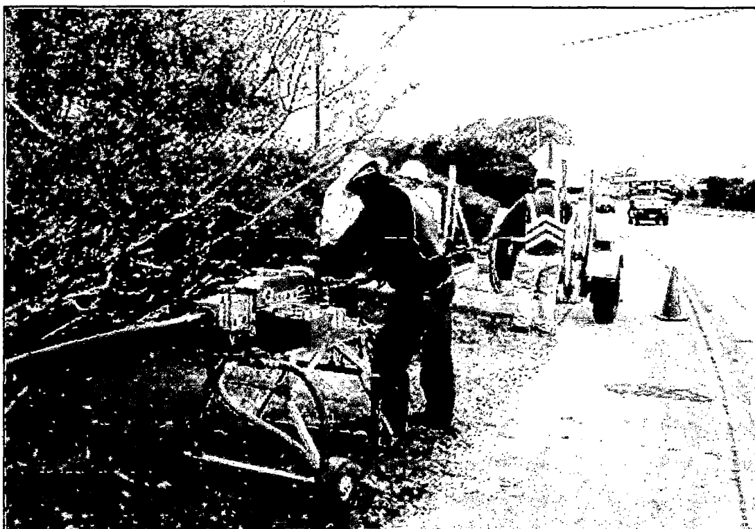
Figura 3.5 Tendido de FO con máquina de Suflaje (Fuente: Delta Equipment)
