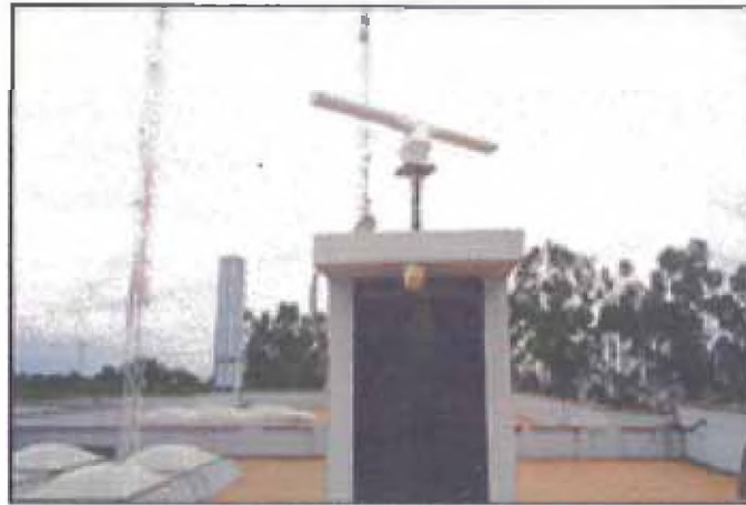
Figura N° 4.7 Características Técnicas del Radar LAWR
