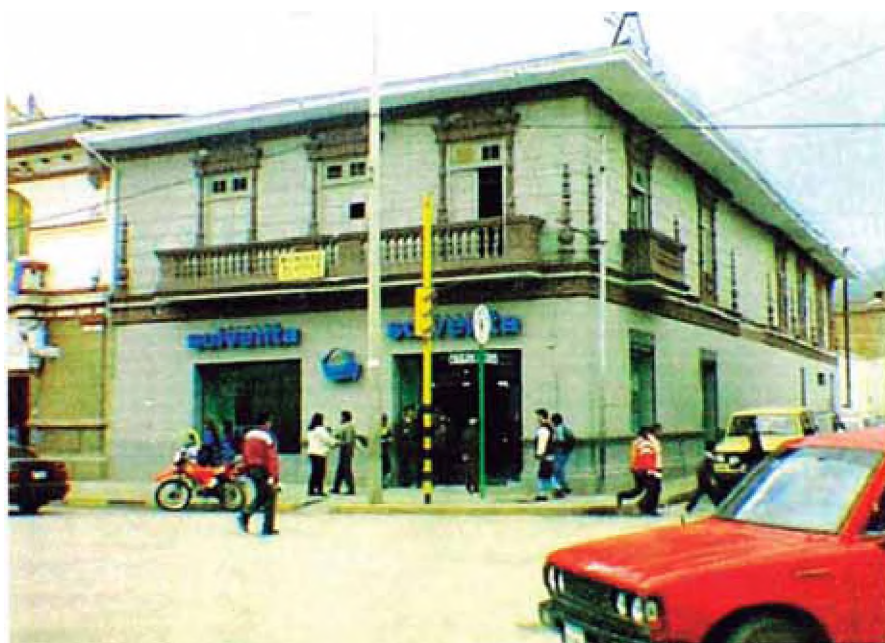
Fachada del local del Banco Solventa – Agencia Huancayo
