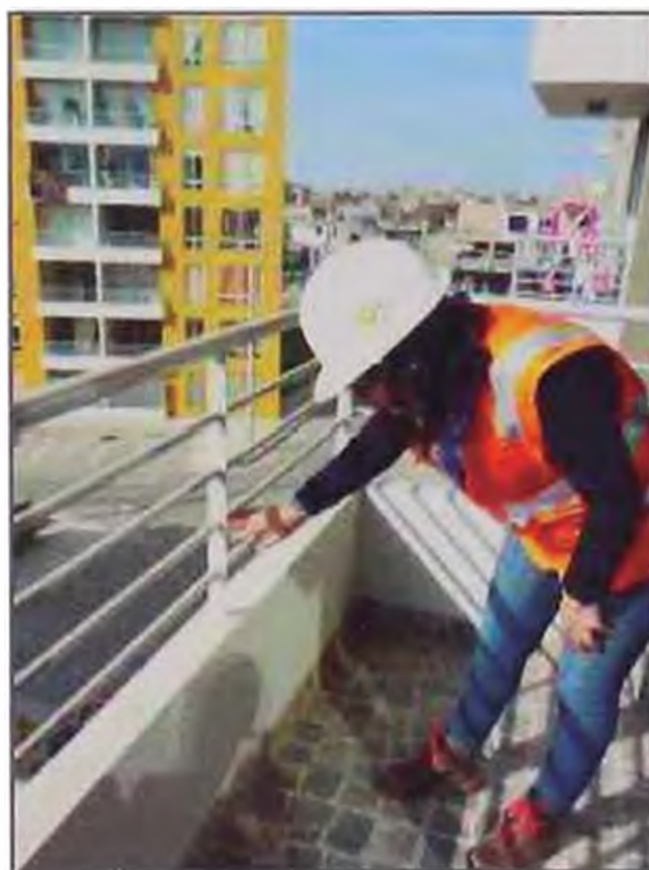
Figura 3.27: Revisión de barandas en balcones
