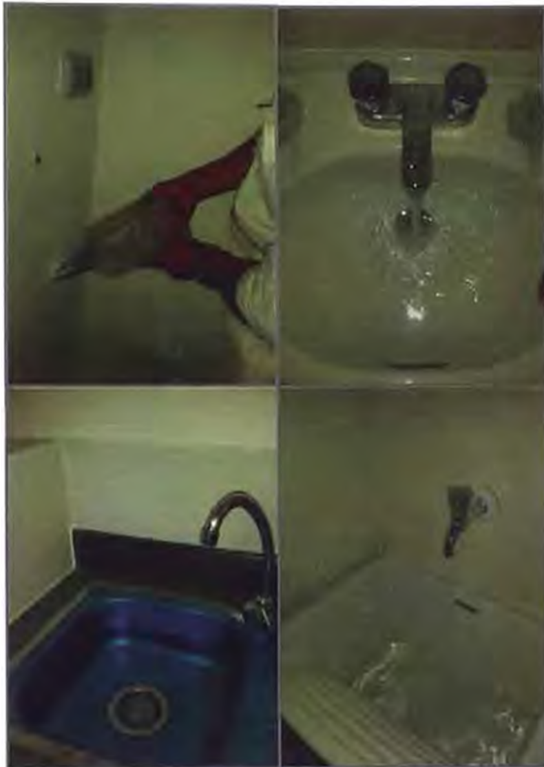
Figura 3.36: Prueba de escorrentía en lavaderos de cocina, baño y lavandería.
