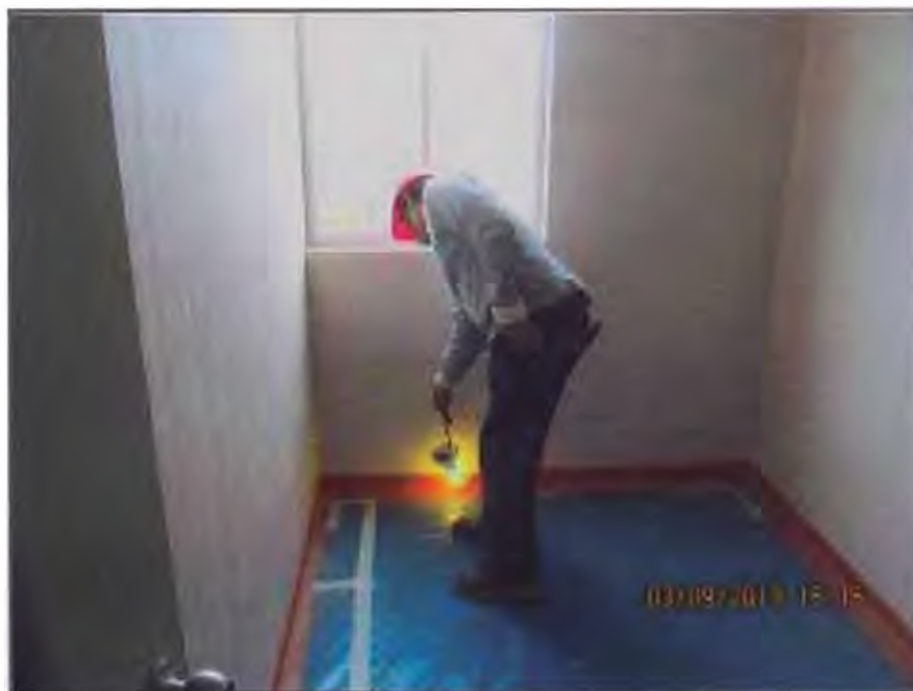
Figura 3.35: Prueba de pilotaje para el tomacorriente
