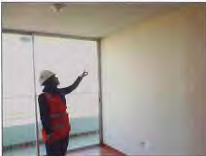
Figura 3.23: Revisión de acabados en los techos
