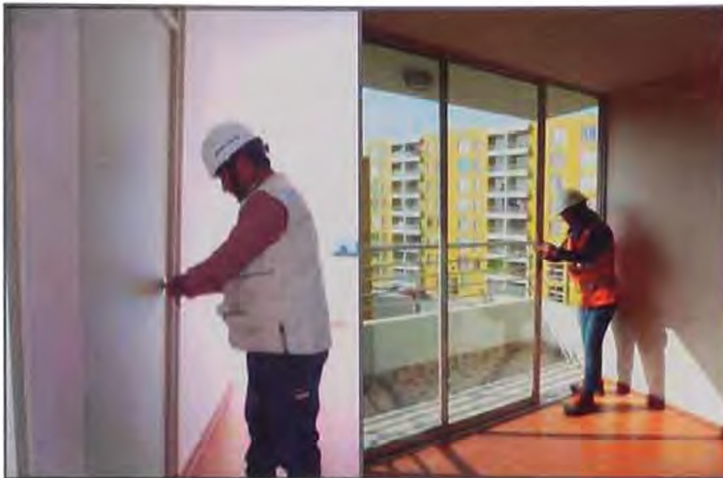
Figura 3.32: Pruebas de funcionamiento en puertas y mamparas.
