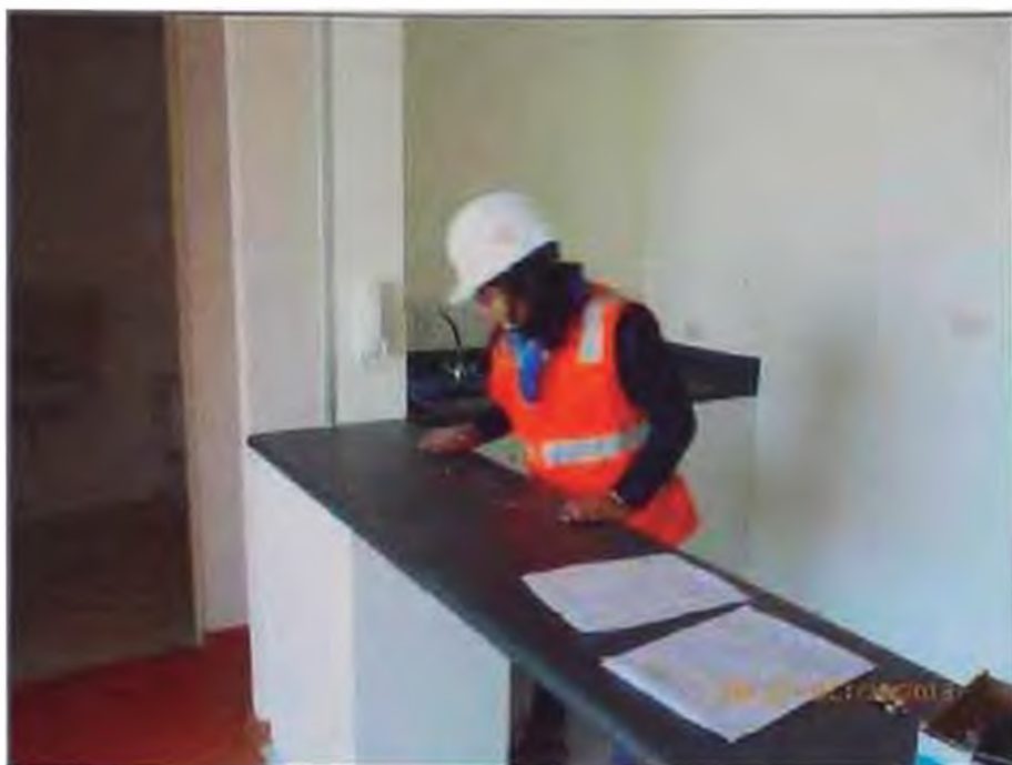
Figura 3.26: Revisión de tablero post-formado
