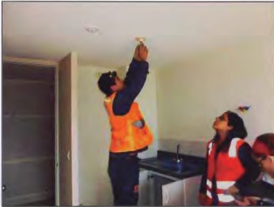
Figura 3.34: Prueba de pilotaje para el centro de luz
