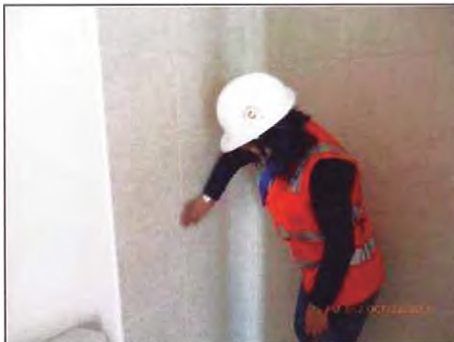
Figura 3.25: Revisión de pintura en paredes interiores
