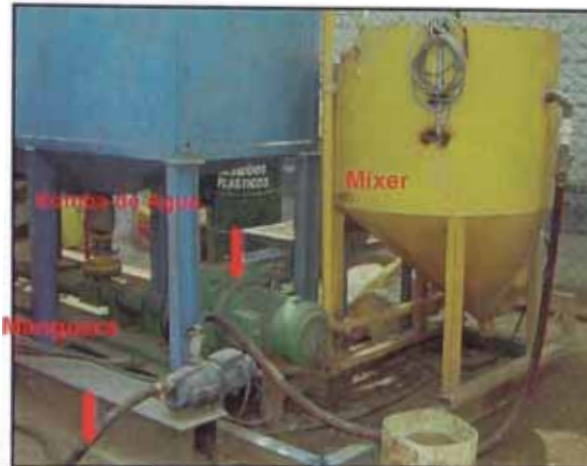
Fotografía 6.35: Mixer y Bomba de agua
