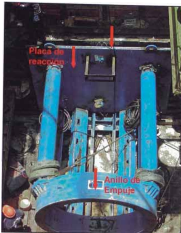
Fotografía 6.23: Anillo de Empuje, Placa de reacción y Muro metálico de reacción.
