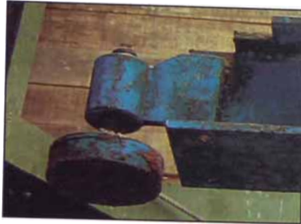
Fotografía 6.26: Nivelador de base
