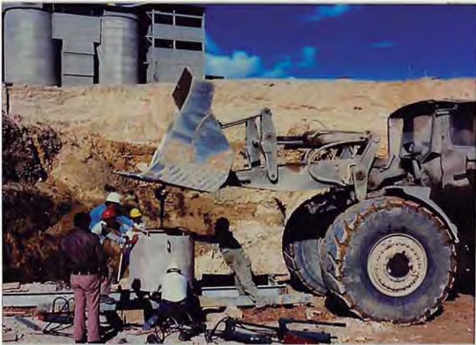
Foto. 3.2... COLOCACION DE LA SOBRECARGA EN LAS VIGAS DE ACERO (Jun.,1988)
