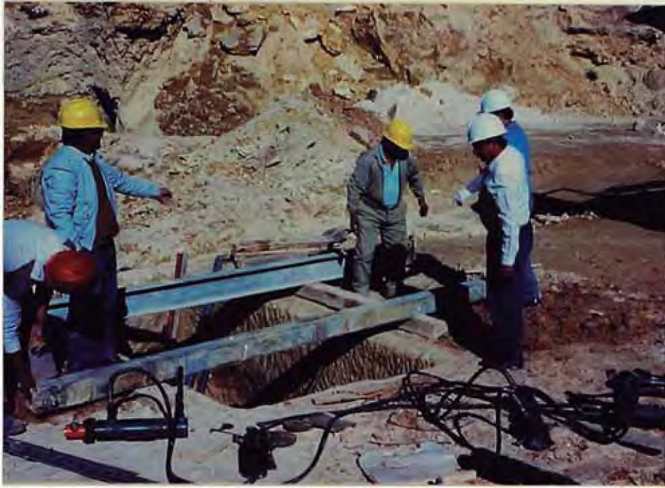
Foto. 3.1... VIGAS DE ACERO QUE SIRVEN DE APOYO A LA SOBRECARGA (Jun.,1988)
