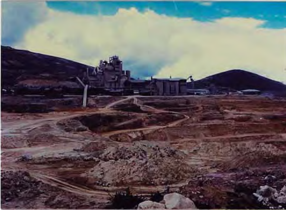
Foto. 2.1... VISTA DE LA FABRICA DE CEMENTO ANDINO Y LA CANTERA DE MATERIA PRIMA. NOTESE LA TOPOGRAFIA ACCIDENTADA DE LA ZONA DE TRABAJO. (Jun., 1987)
