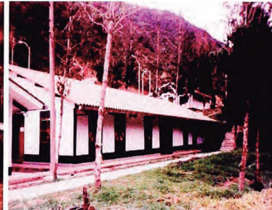
Módulos de oficinas
