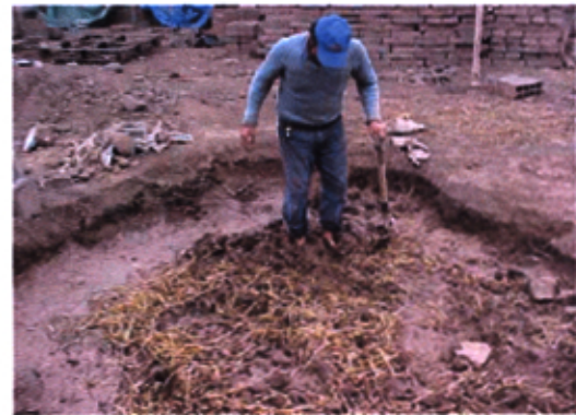
Figura 4: Mezclado del barro
