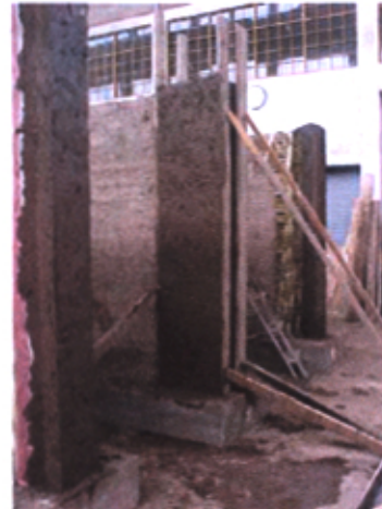
Figura 22: Acabado de muro
