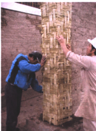
Figura 19: Colocación de estera
