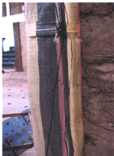
Figura 20: Colocación de costalillo
