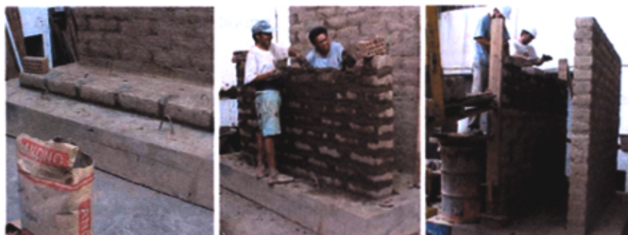
Figura 14: Etapas de Fabricación del muro de adobe sin refuerzo
