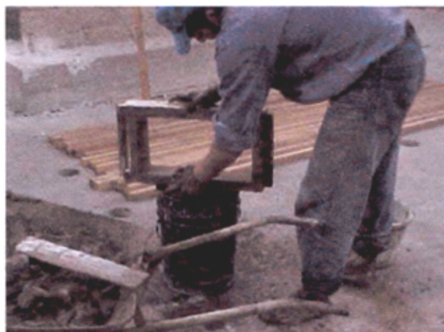
Figura 13: Molde empleado para la fabricación de adobes
