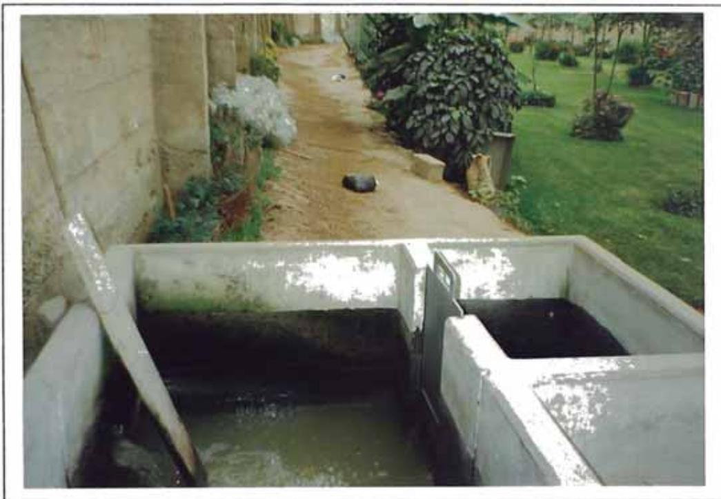
**Ilustración 1: Cámara de captación del desagüe crudo**
