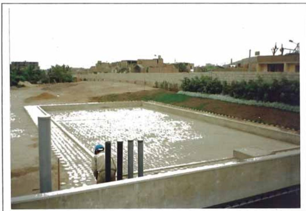
**Ilustración 8: Lecho de secado de lodos**
