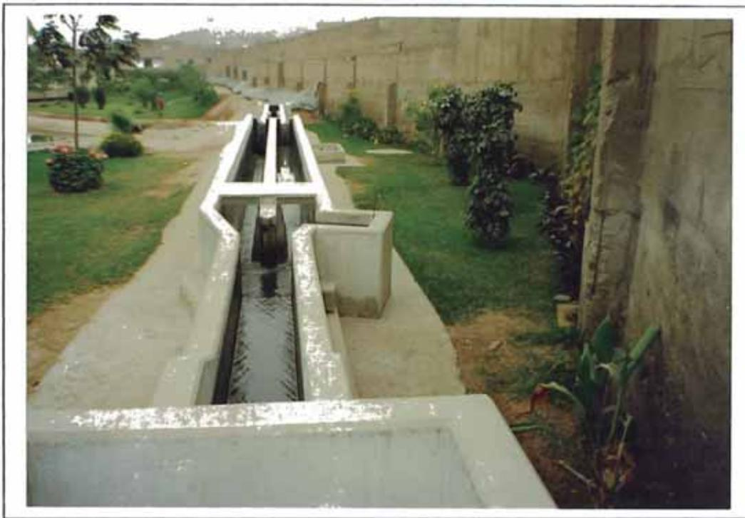
**Ilustración 3: Canal desarenador**
