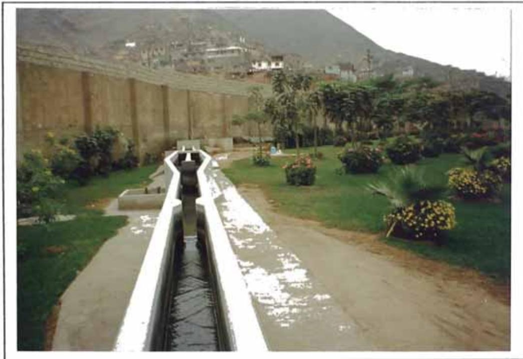
**Ilustración 4: Medidor de caudal Palmer-Bowlus**
