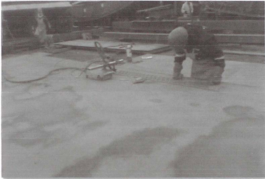
Figura 4.2: Corte de las planchas por medio de los equipos semiautomáticos.
