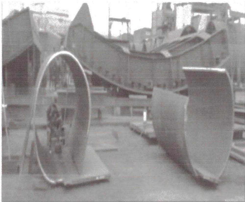
Figura 4.3: Ducto de 2400, luego de ser rolado los extremos.
