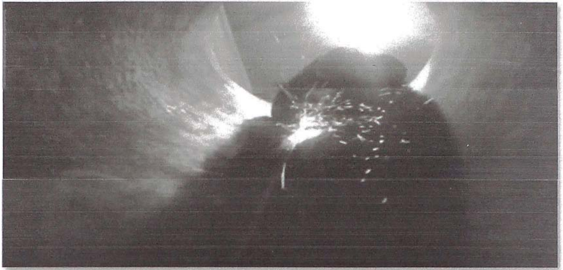
Figura 4.9: Ducto en proceso de soldadura longitudinal interior
