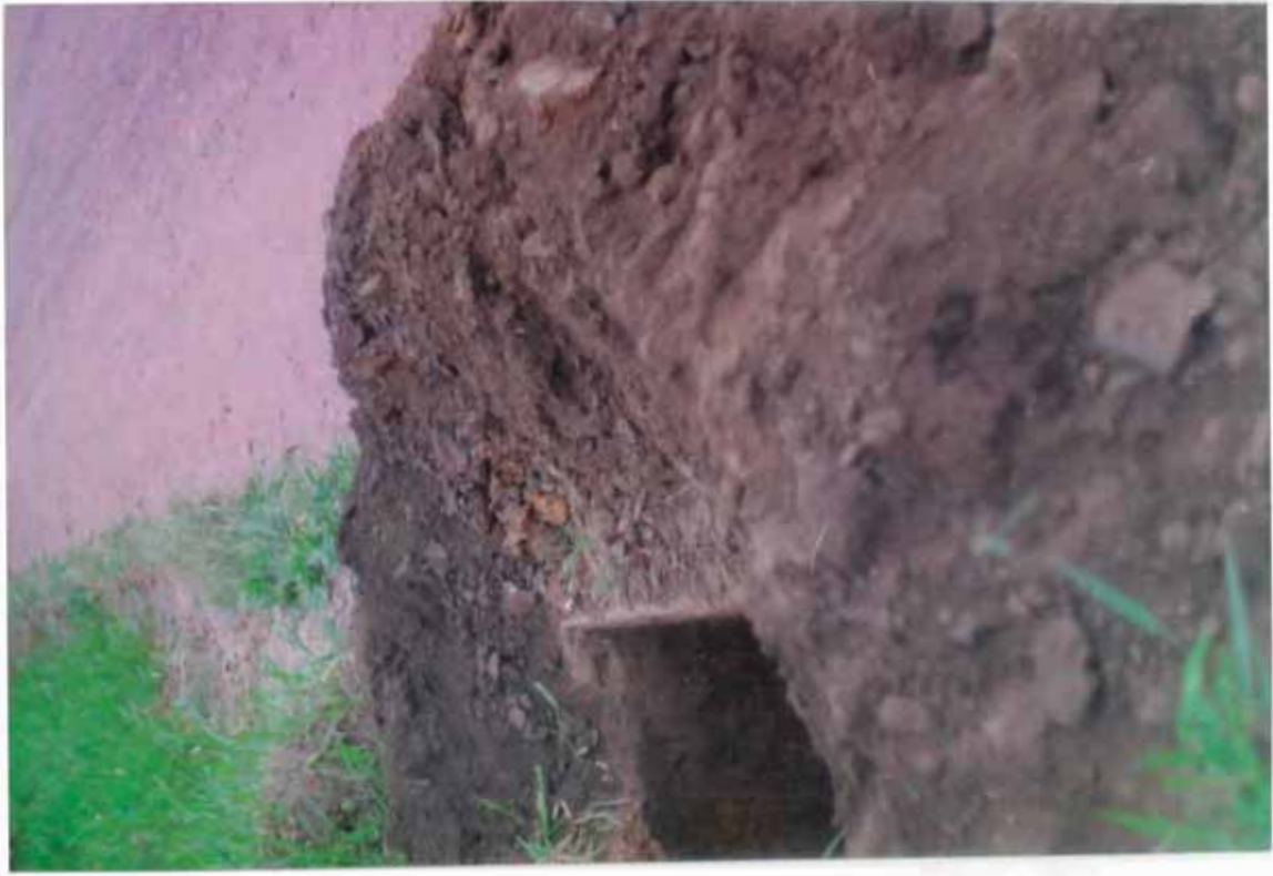
CALICATA Nº 8 TOMADA EN EL KM. 3+500
