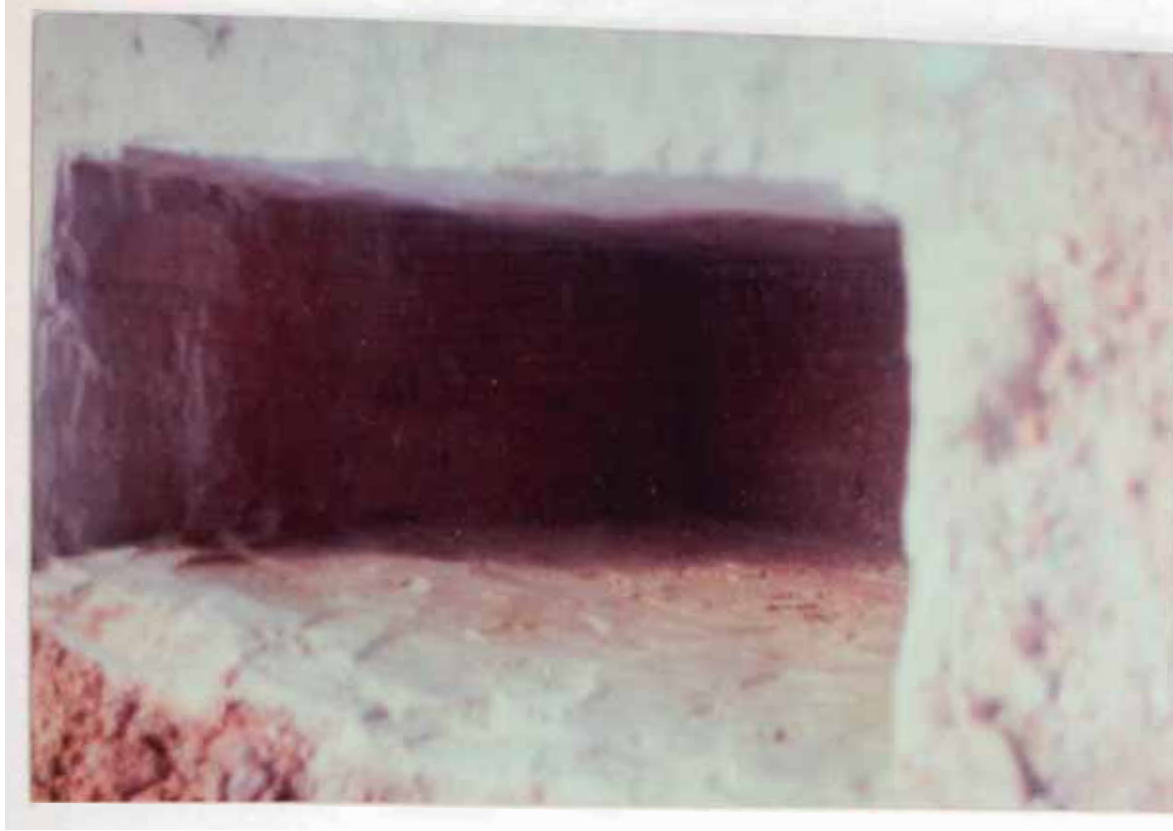
CALICATA NO 4 TOMADA EN EL KM. 1+500
