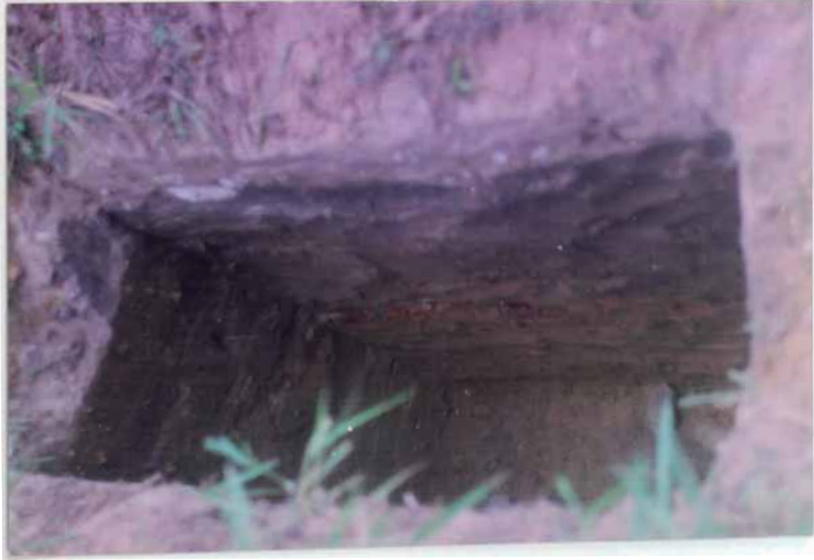
CALICATA Nº 6 TOMADA EN EL KM. 2+500
