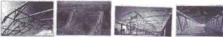
Gimnasio escolar en Saint Vulbas Montaña Rusa en el Parque Asterix Almacén en Scotland Pasarela peatonal Bruxelles
