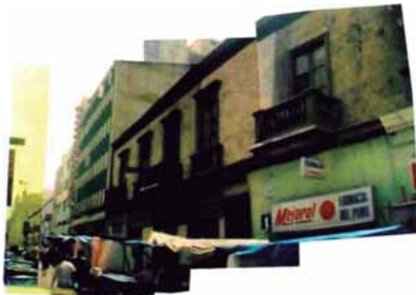
Fachada del Jr. Ayacucho – deteriorada e invadida de ambulantes - año 1995
