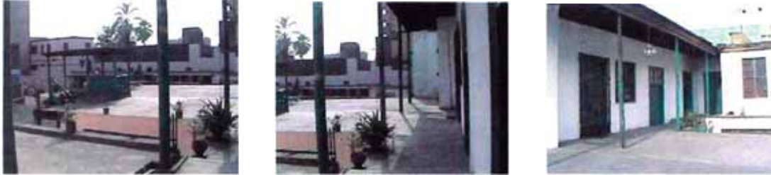
Terraza y corredor del segundo piso.
