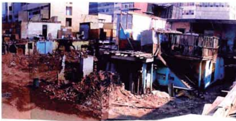
demolición del interior -año1999.
