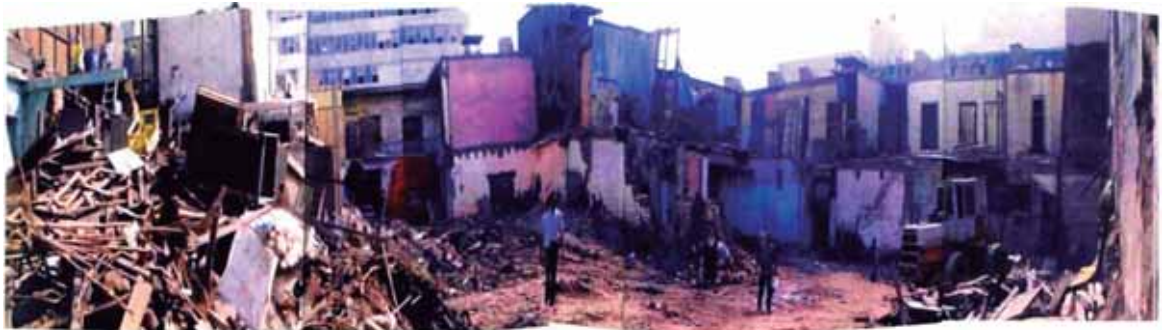
demolición del interior –año 1999.
