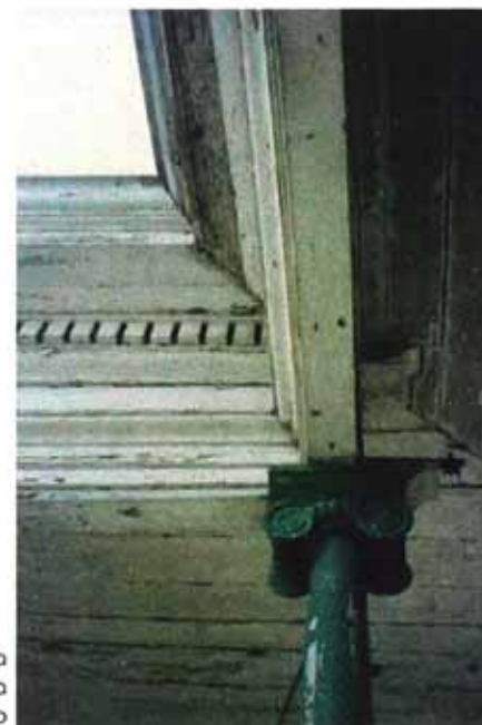
Detalle columna en galería segundo piso
