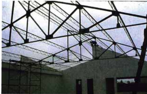
Laboratorios (en construcción)
