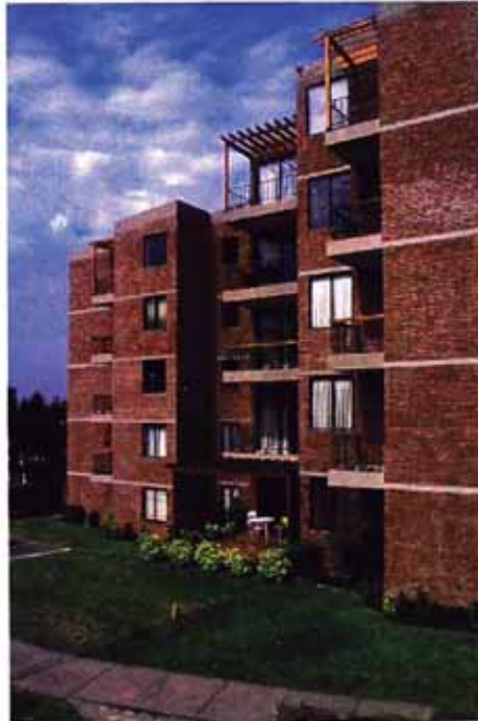
Vista lateral del bloque B. Se aprecian las terrazas de las áreas comunes
