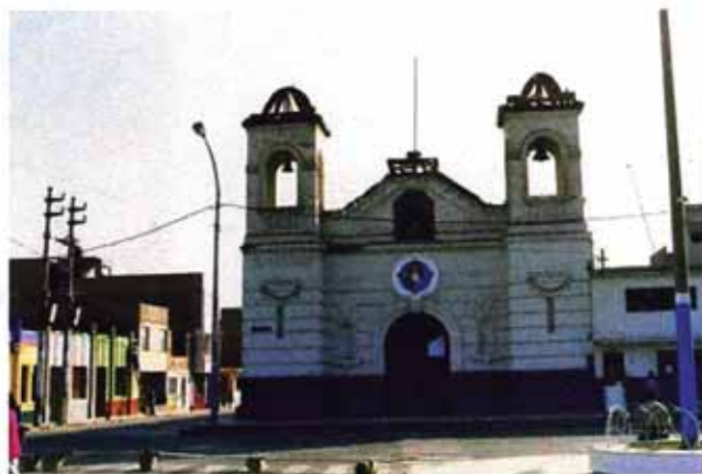
Fachada vista frontal
