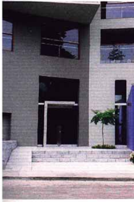
Detalle del ingreso al edificio
