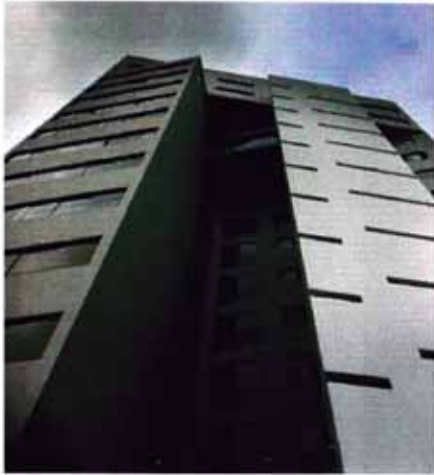
Vista de la fachada posterior
