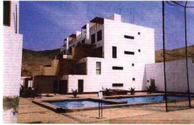
Visto de las piscinas
