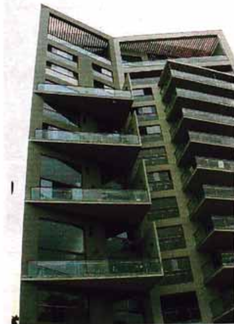
Vista de la fachada principal. Los dúplex en la parte izquierda se diferencian claramente por su doble altura evidenciada en la terraza de los flats ubicados al lado derecho
