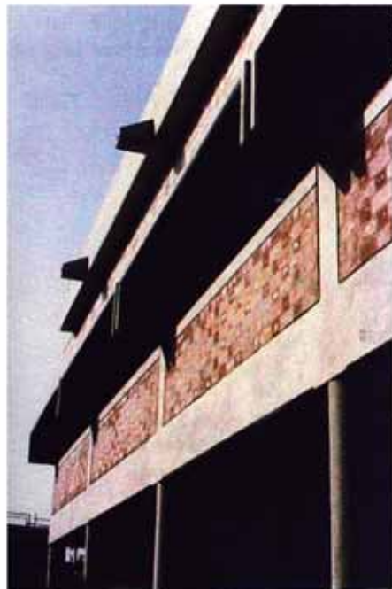
Detalle de parasoles en las ventanas exteriores de la zona de lectura.
