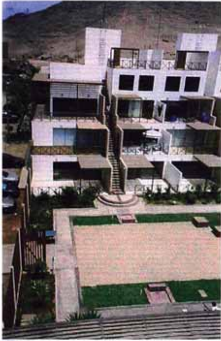
Vista del bloque de ingreso
