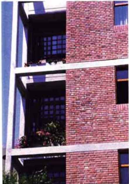
Detalle de materiales en fachada
