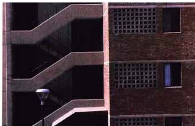
Detalle de fachada
