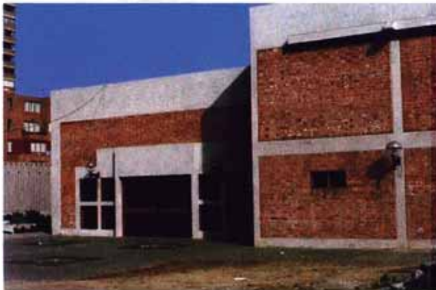
Vista del ingreso al auditorio. Al lado se ve el volumen de servicios con la biblioteca en el segundo nivel
