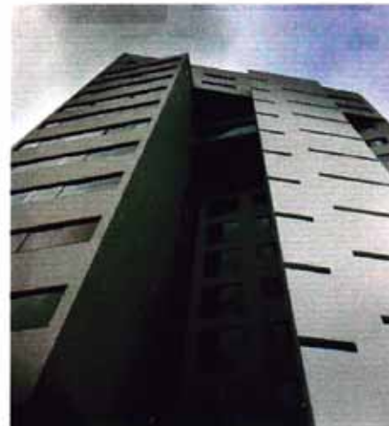
Elevación posterior. Se aprecia la escalera hacia el lado derecho y el volumen de dormitorios de los flats hacia el lado izquierdo, ambos parecen sostener los pent houses en la parte superior.
