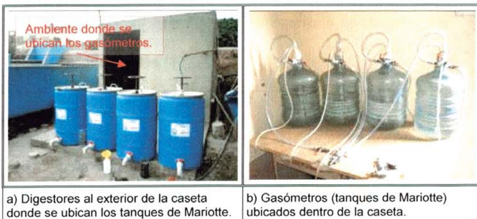
Figura 4.19: Vista del sistema Digestor – Tanque de Mariotte.
