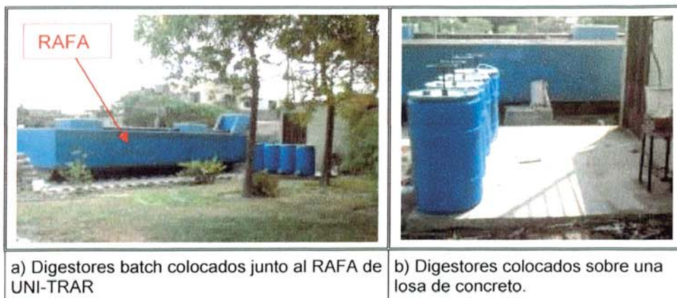
Figura 4.18: Vista de la ubicación de los digestores batch.
