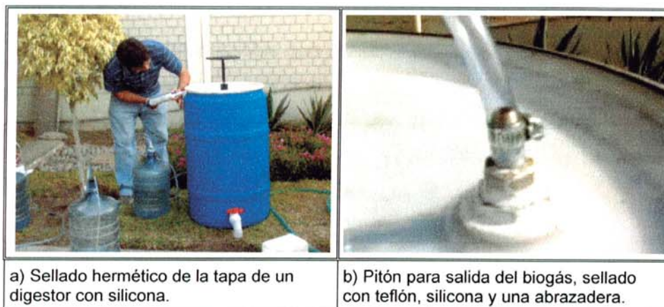
Figura 4.20: Vista de trabajos de hermeticidad de un digestor.
