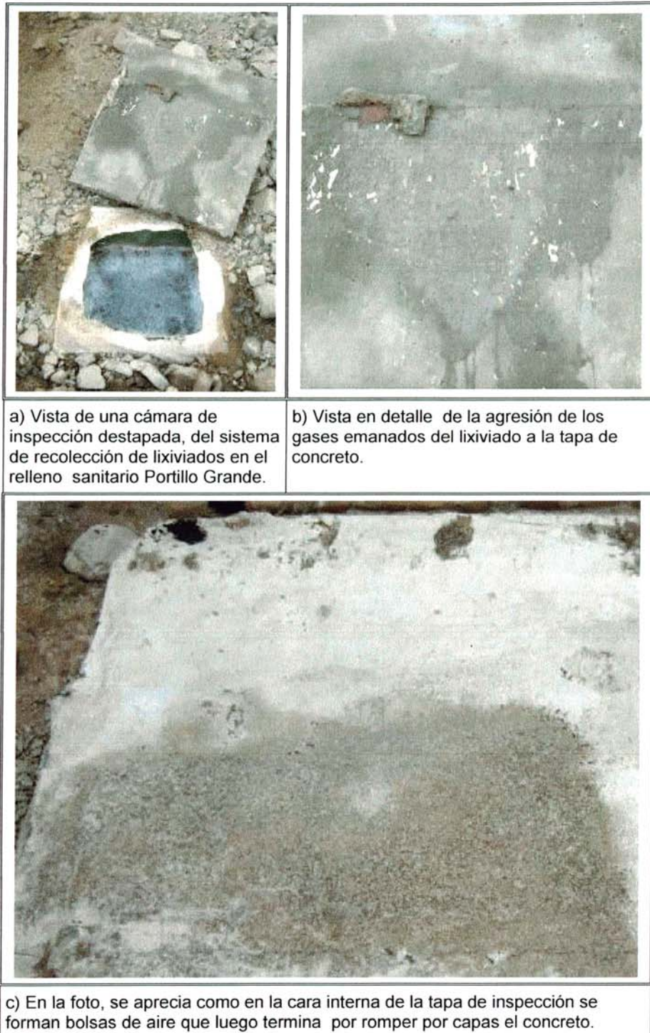
Figura 2.23: Vista de los efectos agresivos del lixiviado al concreto. Fuente: Archivo fotográfico del Dpto. de Planta de Transferencia y Relleno sanitario.
