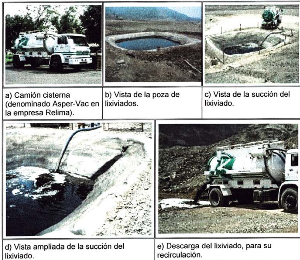
Figura 2.20: Vista de la secuencia del proceso de recirculación de lixiviados, en el Relleno Sanitario Portillo Grande.
