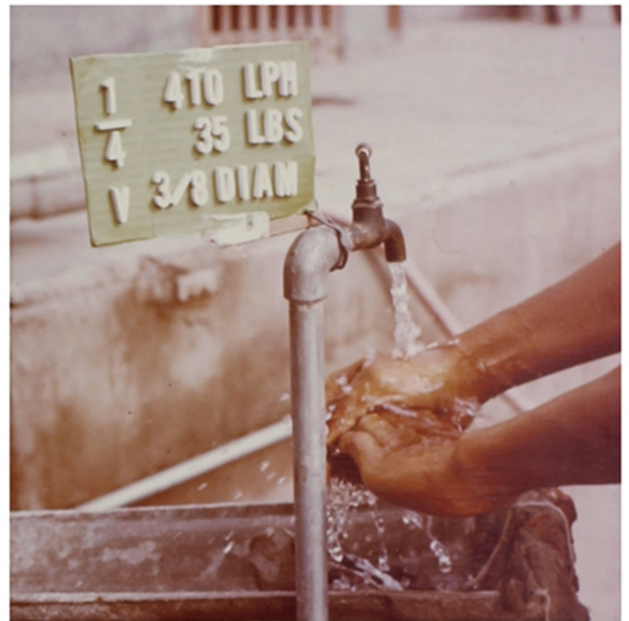
Fig.4.4.- Influencia de la presión de entrada a la conexión en los flujos de salida de los grifos.
