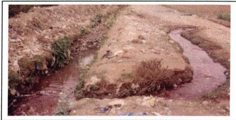
DESCARGA FINAL EMISOR JOSE OLAYA
