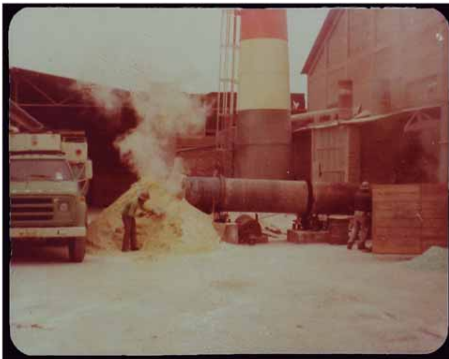
Foto N°6... Se observa que el horno rotativo produce humos debido a la combustión del petróleo, y el polvo debido al secado de la sílice
