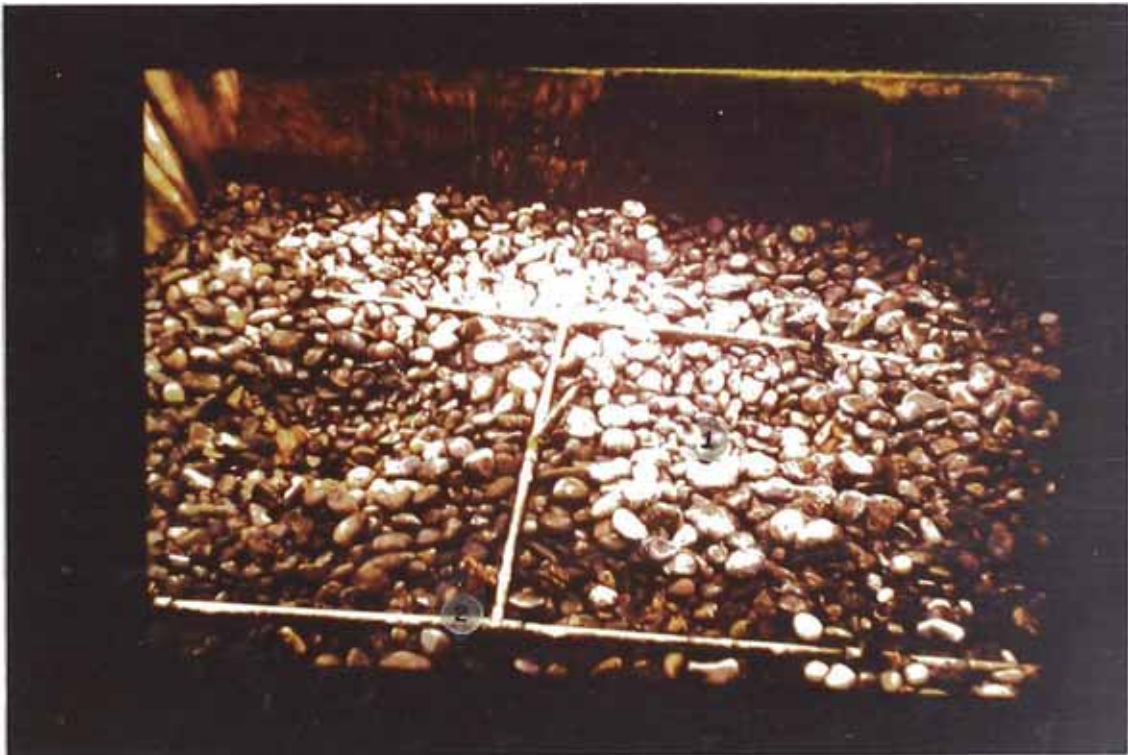
FOTOGRAFIA N° 5 1.- LECHO FILTRANTE 2.- TUBERIA DE DISTRIBUCION DE FLUJO
