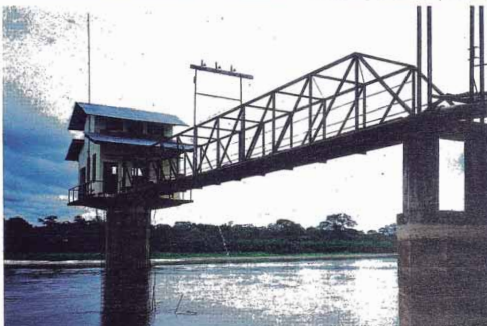
Foto 3: Captación N°1, reconstrucción de caisson
