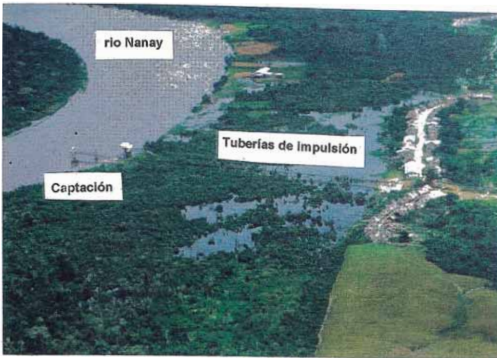
Foto 1: Vista aérea de captación rio Nanay (crecida) y líneas de impulsión agua cruda
