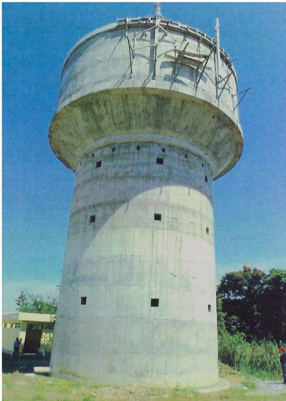
Figura N° 4.1: Reservorio elevado tipo Intze con soporte cilíndrico
