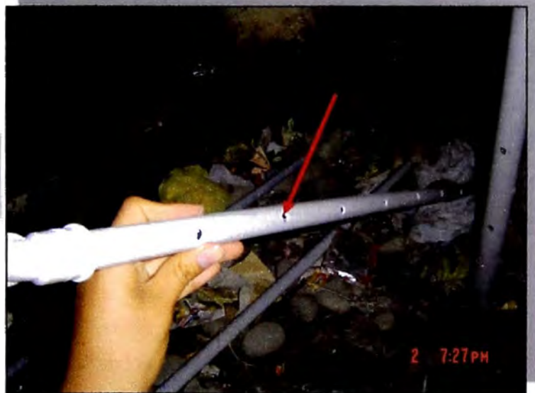
Foto N° 4.5.15: Orificios de \frac{1}{2} " de diámetro y espaciadas cada 10cm.
