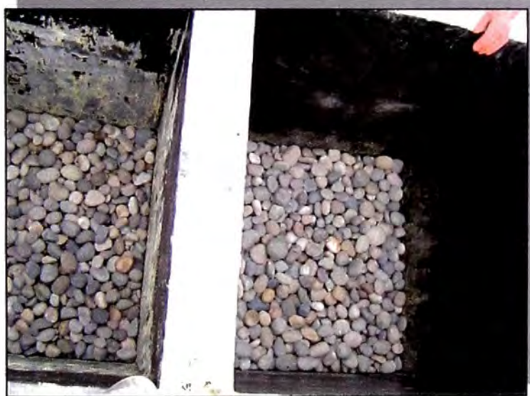
Foto N° 4.5.7: Vista de las Celdas Piloto con la capa de 10cm de grava dispuesta para el drenaje de lixiviados.
