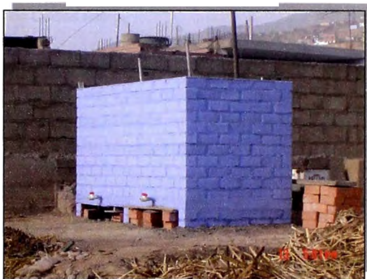
Foto N° 4.2.1: Vista exterior de las Celdas Piloto
