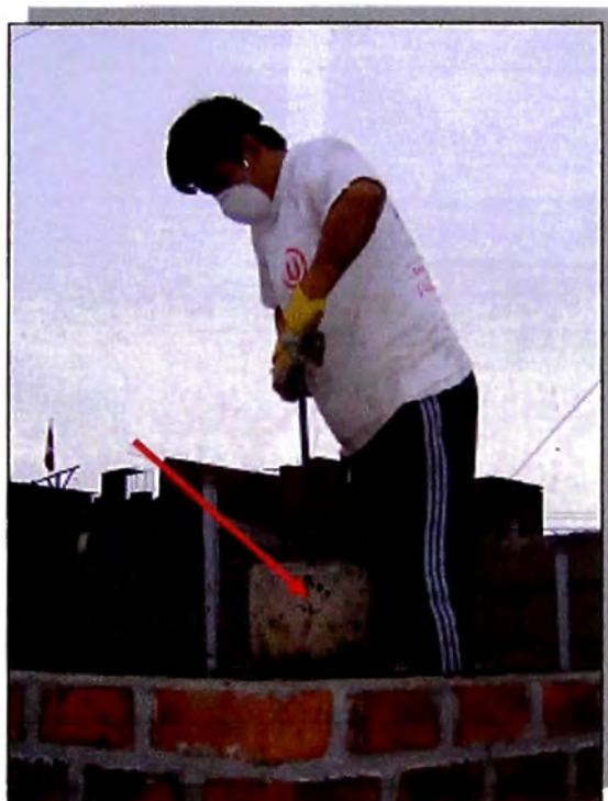
Foto N° 4.5.12: Proceso de compactación en última capa, haciendo uso de un pisón manual, densidad esperada comprendida entre 0.5 y 0.7 Ton/m 3
