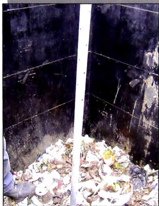
Foto N° 4.5.9: Llenado de la 1° Capa de 40cm de Residuos Sólidos.
