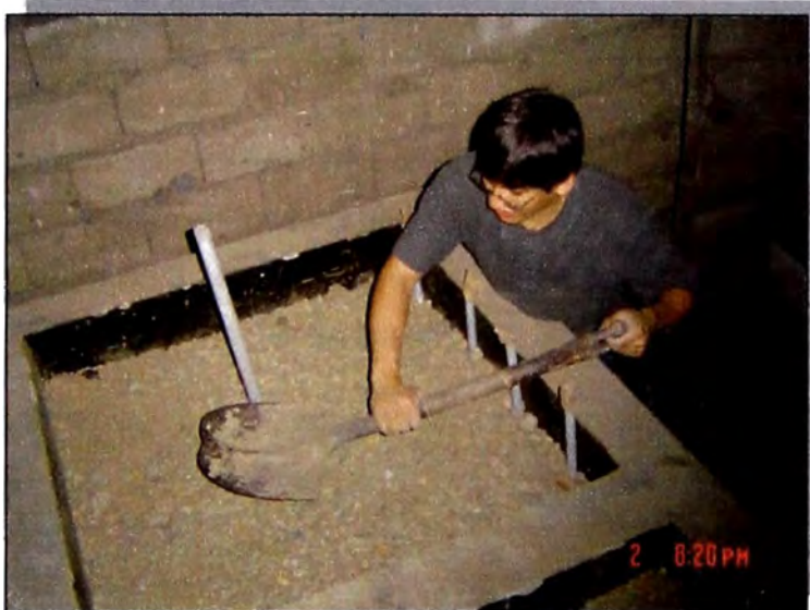
Foto N° 4.5.20: Conformación de la cobertura de las Celdas Piloto.
