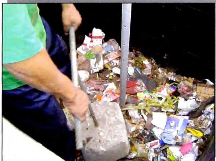
Foto N° 4.5.10: Proceso de Compactación de Residuos de la 1º Capa.
