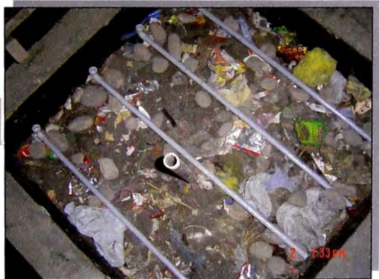
Foto N° 4.5.16: Tuberías de distribución de lixiviados.
