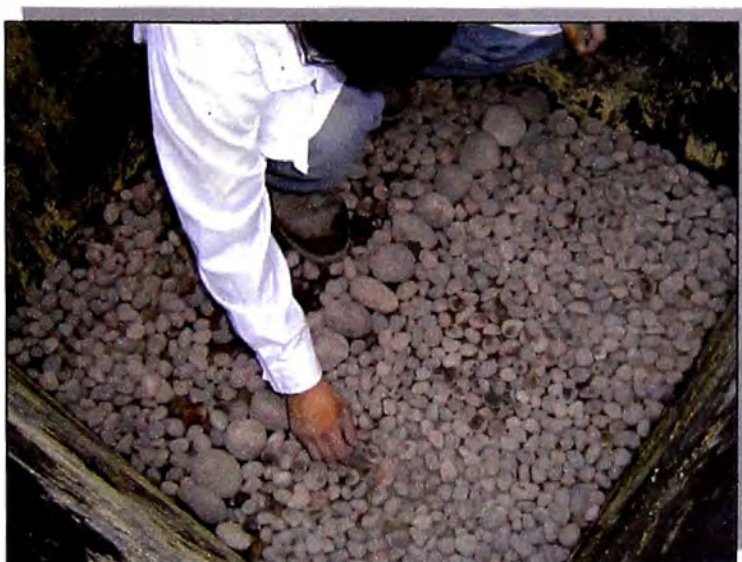
Foto N° 4.5.5: Colocación de grava para el drenaje de los lixiviados.
