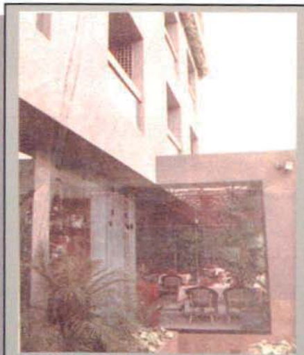
DETALLE DE FACHADA
