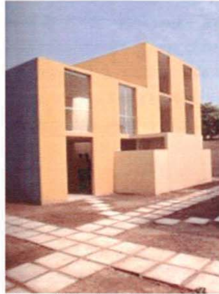
Fig. 2 Viviendas del Programa MIVIVIENDA-Los Próceres.
