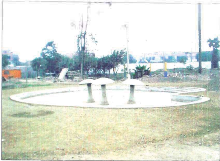
VISTA PATERA EN CONSTRUCCION
