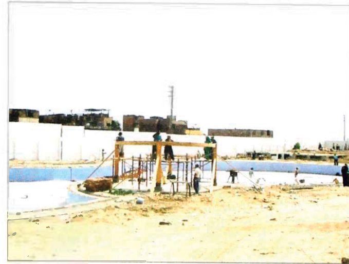
VISTA OBRAS PRELIMINARES EN MADERA DE MALOCA
