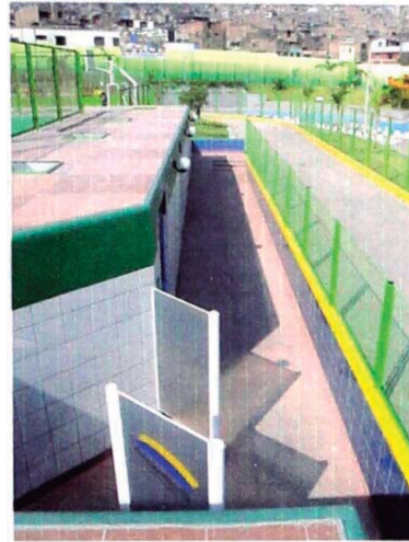
VISTA CORREDOR DE ACCESO
