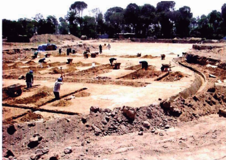
VISTA DE ZANJAS PARA TENDIDO DE TUBERIAS DEL SISTEMA HIDRAULICO
