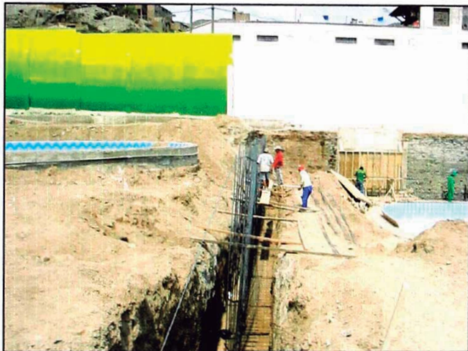
VISTA EXCAVACION DE ZANJAS PARA MURO CONTENCIÓN
