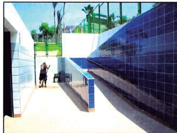
VISTA CORREDOR DE ACCESO
