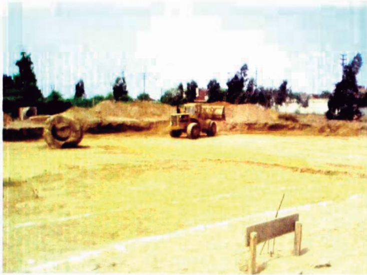
VISTA EXCAVACION POZAS PISCINA RECREATIVA
