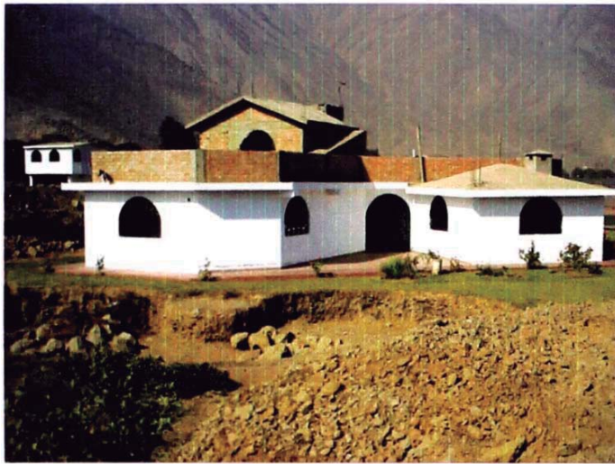
VISTA FACHADA POSTERIOR Y EXCAVACION POZA DE PISCINA
