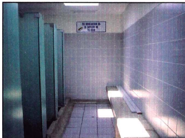
VISTA INTERIOR DUCHAS Y VESTUARIOS
