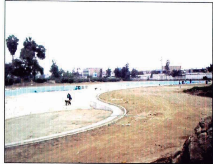
PISCINA EN PROCESO DE ENCHAPE CERAMICO
