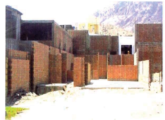
VISTA DE LA EDIFICACION EN OBRAS PRELIMINARES
