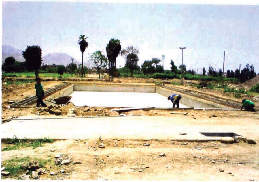
VISTA DE LA REMODELACION DE LA PISCINA SEMIOLIMPICA
