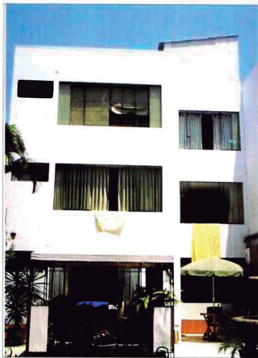
VISTA FACHADA INTERIOR
