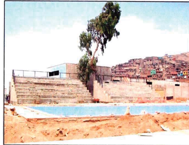
VISTA PISCINA SEMIOLIMPICA EN ACABADOS FINALES
