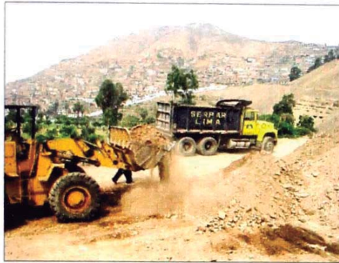
VISTA DE LA PREPARACION DEL TERRENO PARA EL VIVERO
