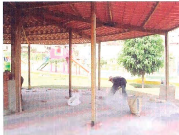
VISTA DE LA PREPARACION DEL PISO ADOQUINADO
