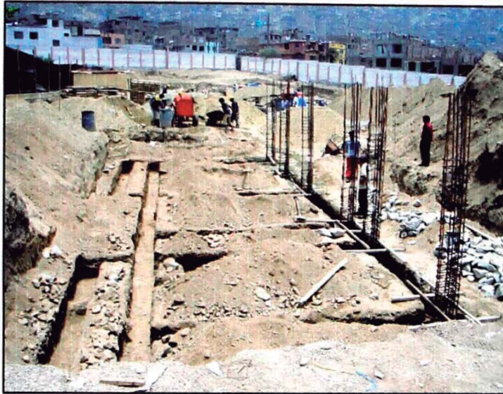
ETAPA DE CIMENTACION Y COLUMNAS
