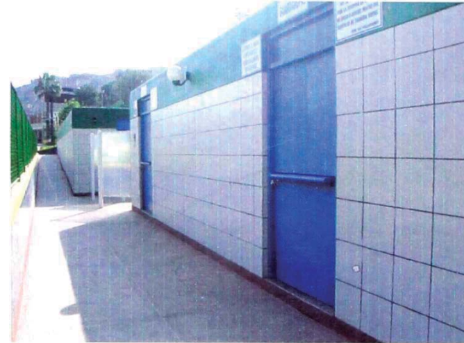
VISTA EXTERIOR ZONA DE GUARDARROPAS
