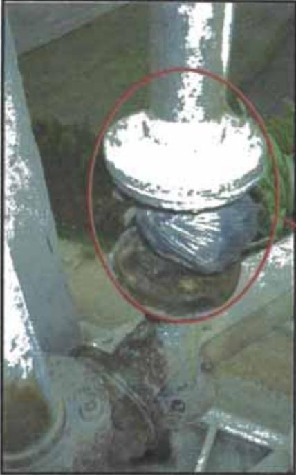
Reparación artesanal de emergencia efectuada sobre los accesorios a la salida del reservorio.
