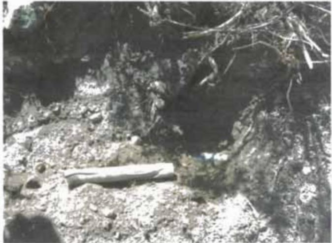
Existen daños puntuales y recurrentes (aprox. 5 reparaciones al año) en la línea de conducción debido a la caída de rocas sueltas en un tramo de aproximadamente 500m, los cuales se encuentran instalados a poca profundidad (h prom.= 0.20m.)
