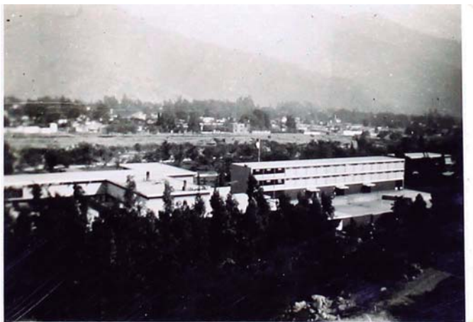
TOMA N° 4.- Block para obreros de la Colonia Climática, a la derecha. Al centro el local de la Administración y a la izquierda, el comedor.
