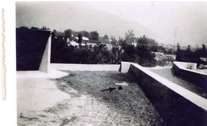
TOMA N° 9.- La flecha indica la ubicación del buzón de aforo, al lado se encuentra el canal de Descarga. Es en este lugar donde quedará ubicado el buzón con caída y la descarga actual servirá como by pass.
