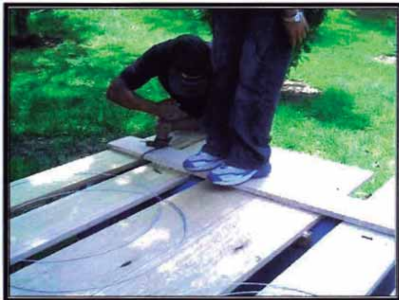
Foto 08 y 09: Se comienza a unir la plataforma con los cuatro cilindros atándolos con sogas y alambres de manera adecuada.
