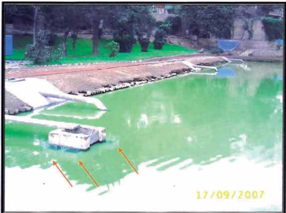
Fotos: 54 y 55: Este es el momento donde colocamos los sistemas batch, que son tres unidades con concentración de bacterias distintas
