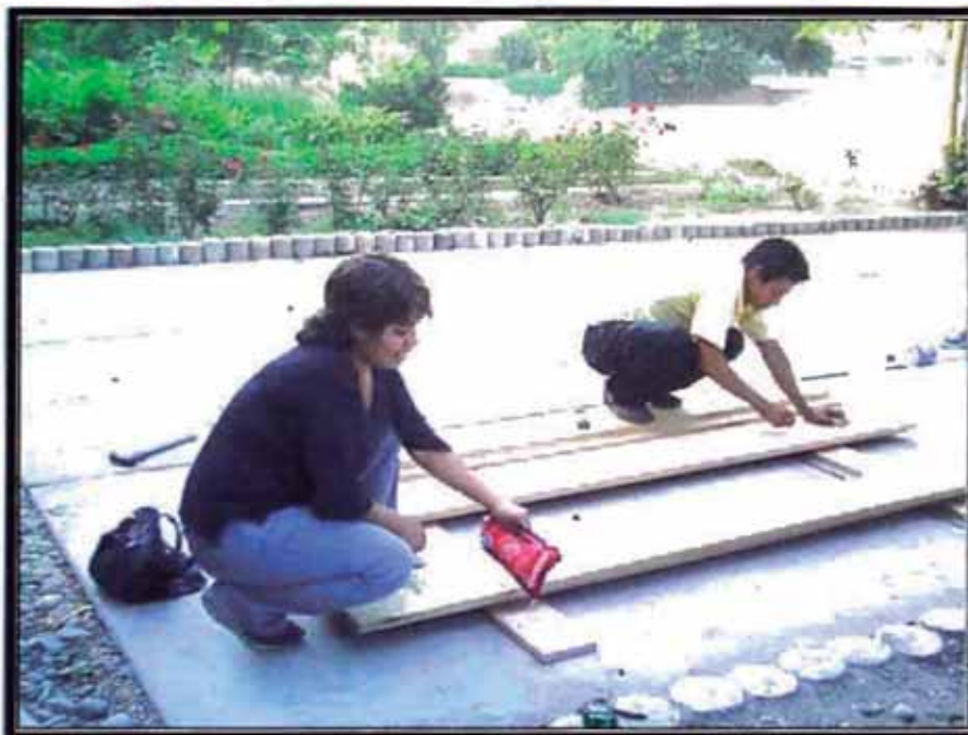
Foto 07: Se muestra como se empieza a construir la plataforma de la balsa artesanal.
