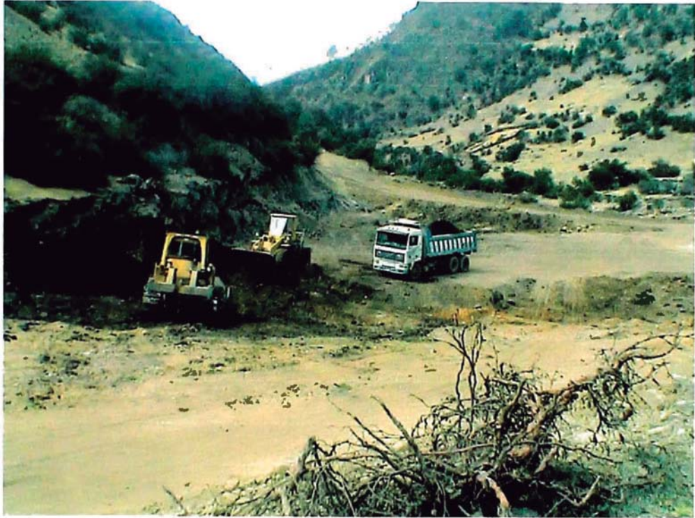
Habilitación de la poza de lodos N° 4
