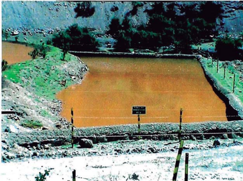
Lodos frescos, obtenidos de la operación de limpieza Del sedimentador
