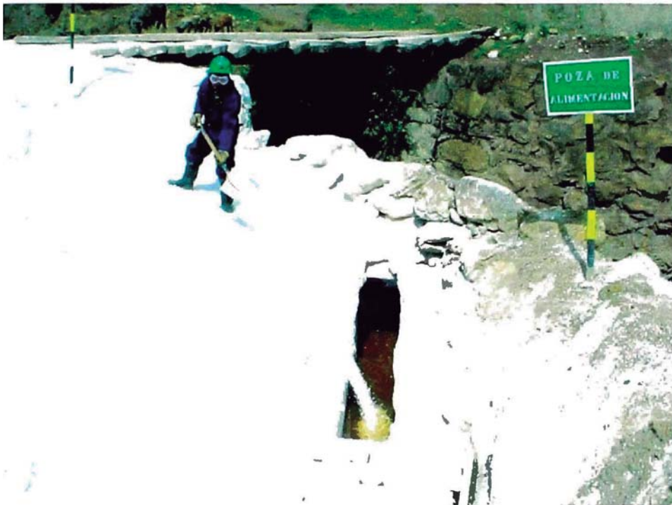
Personal de la Cia minera Julcani, dosificando cal En seco Para El proceso de neutralización
