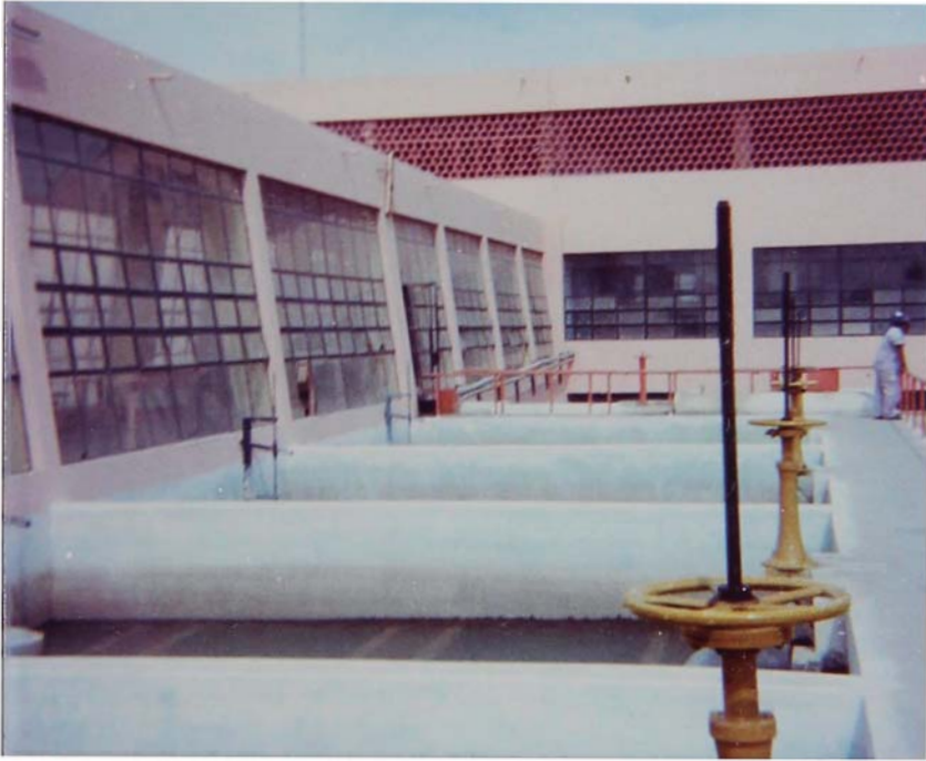
Casa de Quimica y vista de los filtros.
