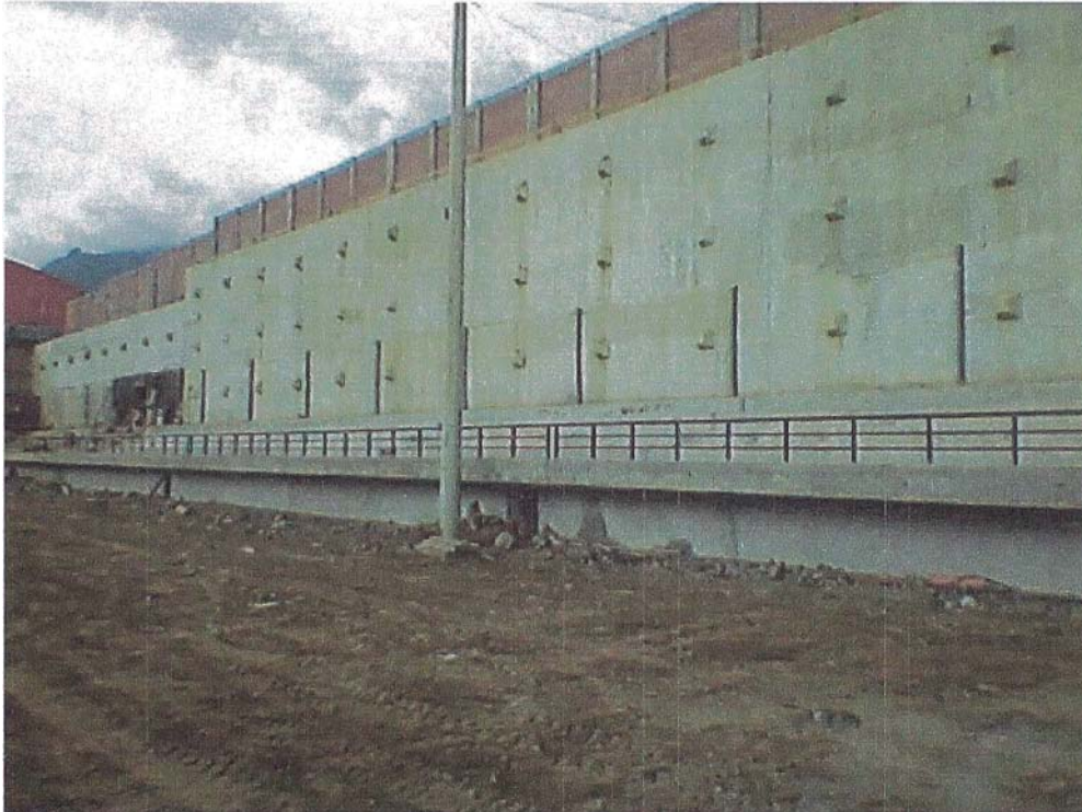
Figura N°3.23.- Vista de Anclajes Instalados
