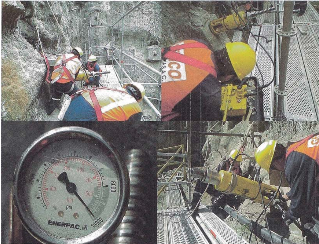
Figura N°3.27.- Procedimiento de Tensado de Anclaje
