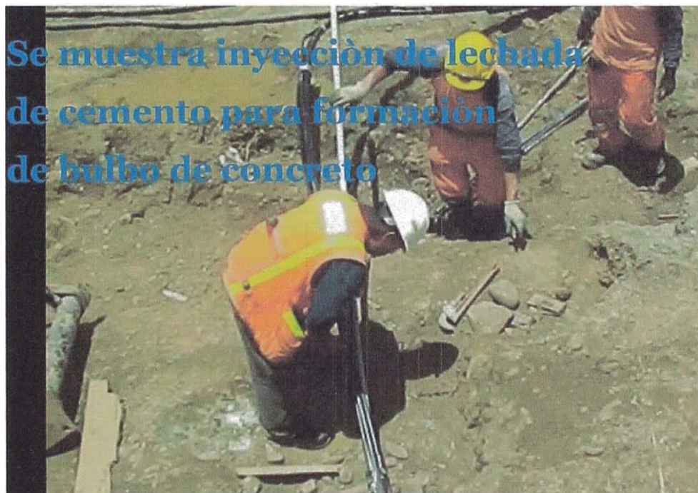
Figura N°3.24.- Inyección del Bulbo
