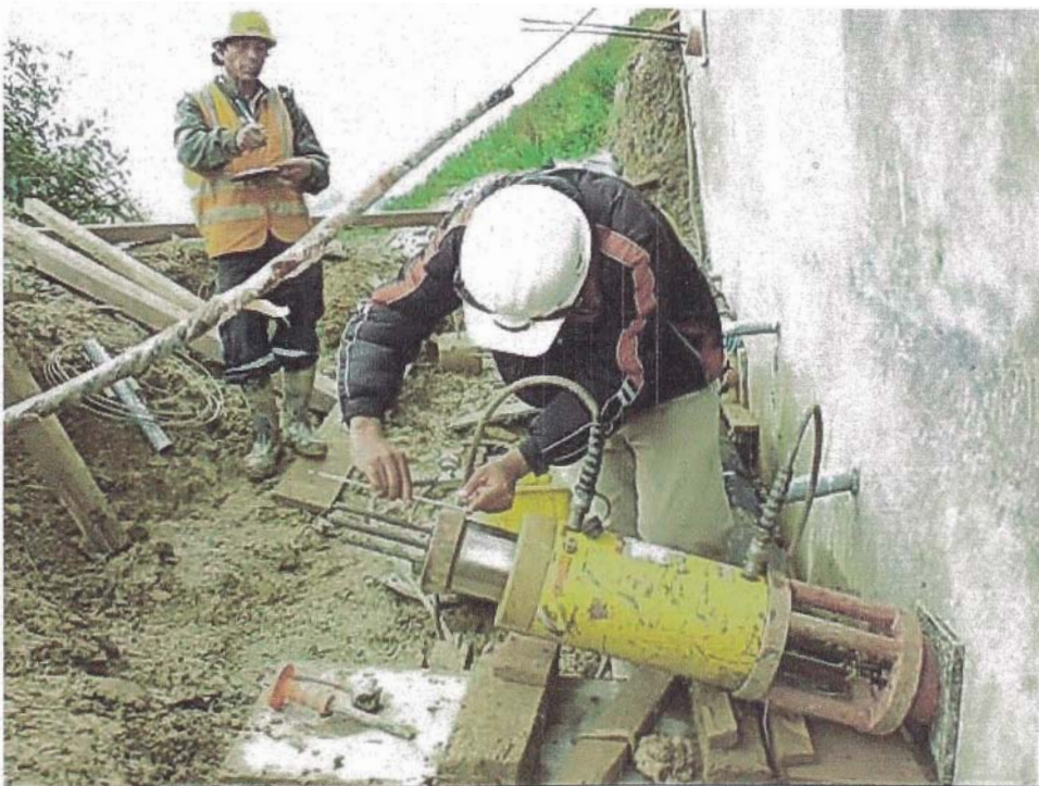
Figura N°3.26.- Protección de Anclajes con dado de concreto.
