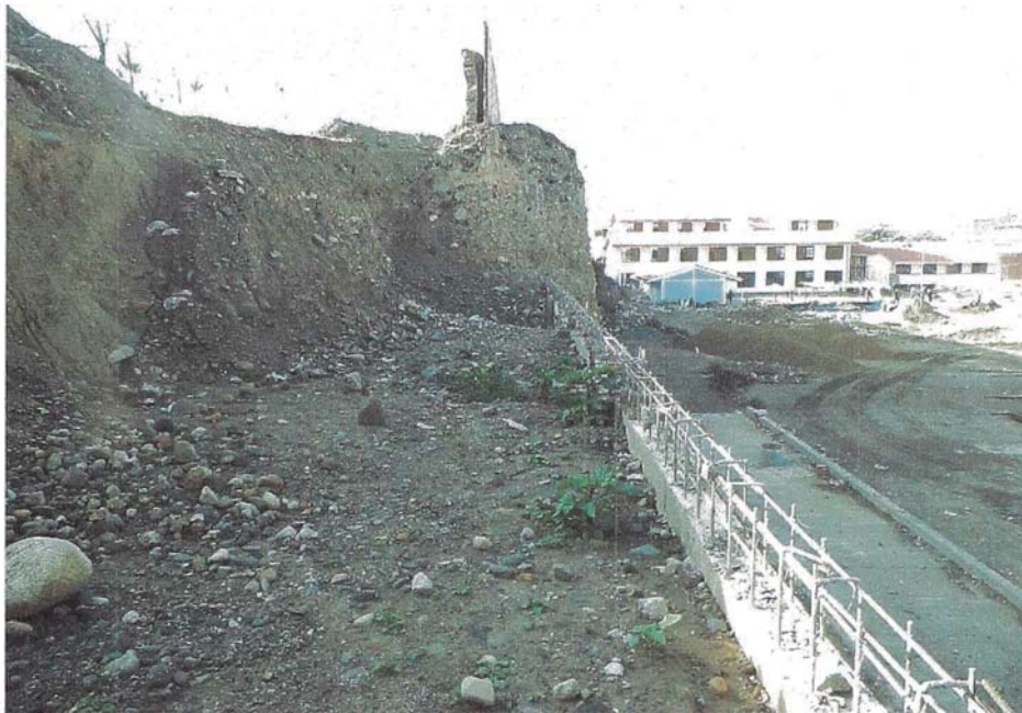
Figura N°3.20.- Movimiento de Tierras
