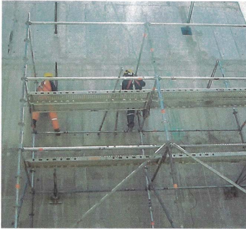
Figura N°3.25.- Suministro e Instalación de Cabezales Tensado
