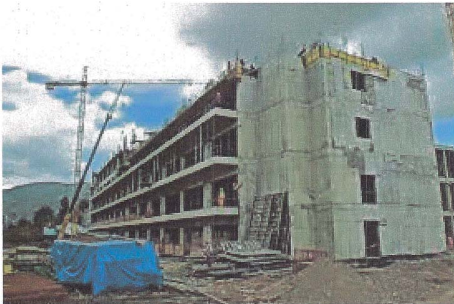
Figura N°3.7.-Ejecución de Pabellón de Institución Educativa Emblemática
