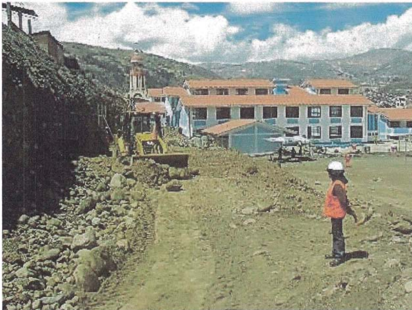
Figura N°3.13.- Perfilado de Talud sobre Terraplén en Tribuna Oriente de Campo de Fútbol.
