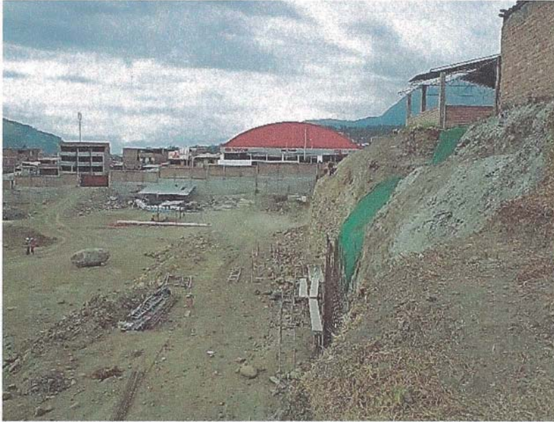
Figura N°3.12.- Vista Panorámica de Talud de Tribuna Oriente
