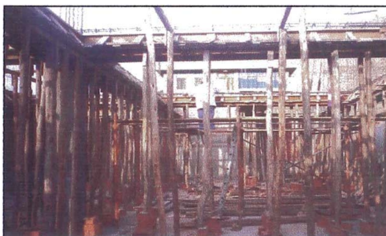
Foto (65). Desarrollo de la estructura de una vivienda familiar.
