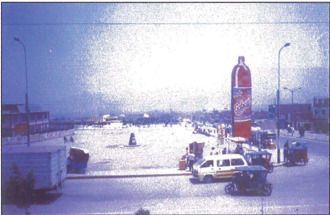
Foto (42). Vías de tránsito para el transporte en la comunidad, estas comprenden las Av. Principales, como la Av. 15 de Julio.
