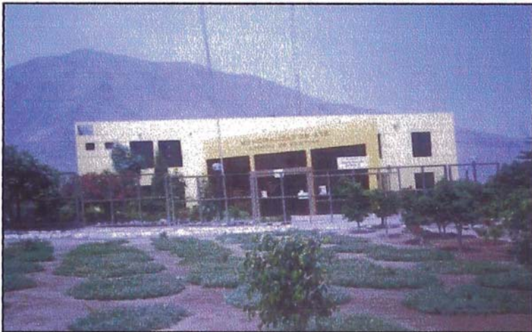
Foto (23). Equipamiento de Gestión. Se muestra la Agencia Municipal de Huaycán.
