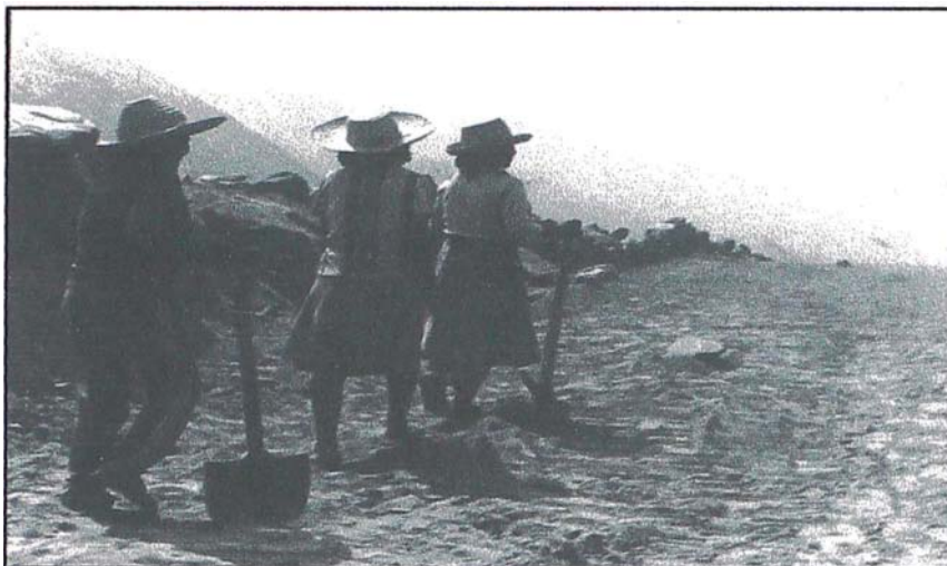
Foto (1). Habilitación de las vías de acceso. En faena comunal de los pobladores, 20 de Abril de 1986.
