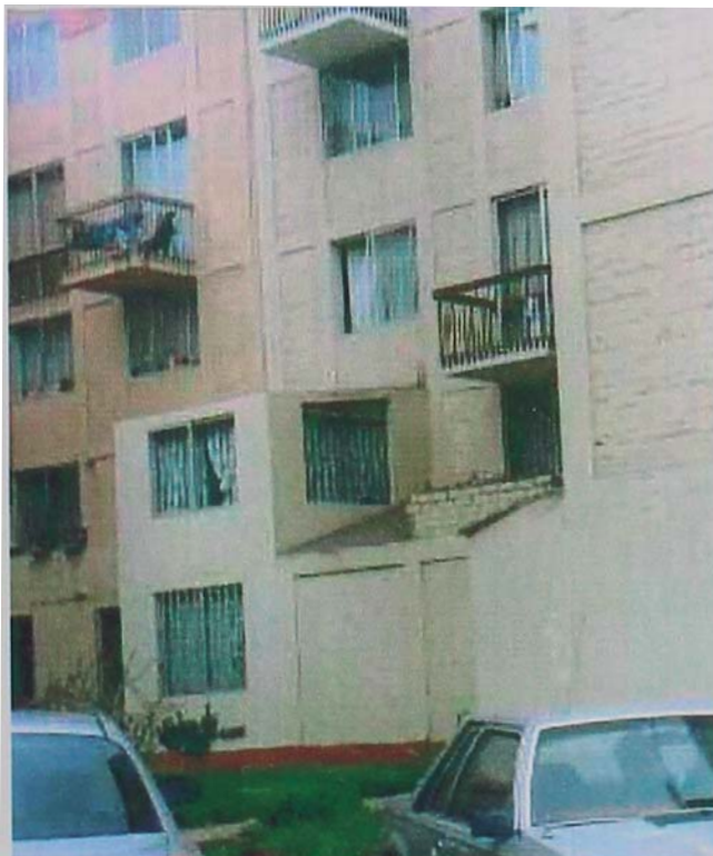
Foto N°2 .- Vista Frontal Edificio B – Dpto. 102.
