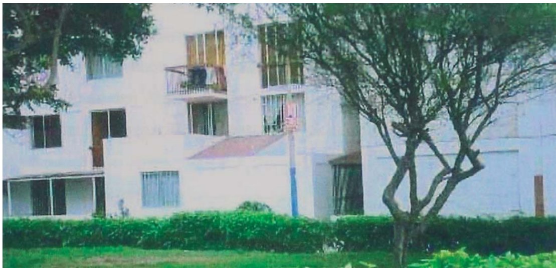
Foto N° 7 .- Vista frontal Edificio N – Dpto. 102.
