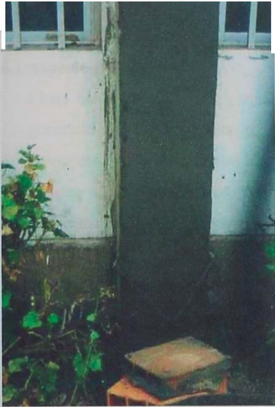
Foto N° 09 columna exterior a construcción e i tente tarrajada
