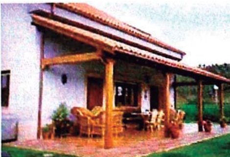
Rehabilitación General en madera Asturias, España.
