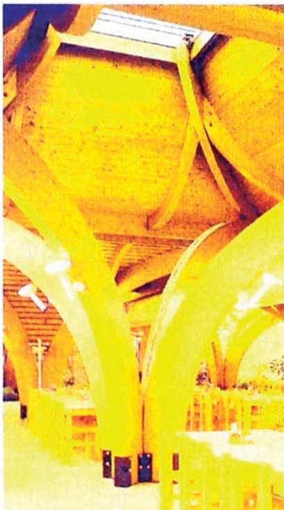
Las construcciones con laminas encoladas son mas resistentes que las macizas
