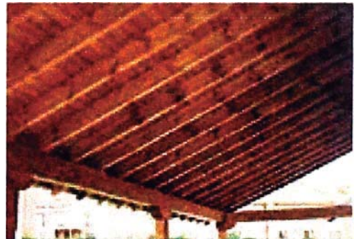
Cobertura convencional en madera y Detalle, en Asturias, España. Porche de 12 m.
