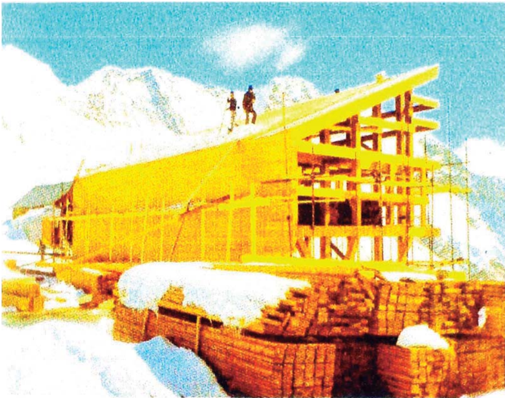
Refugio de alta montaña totalmente construido en madera.
