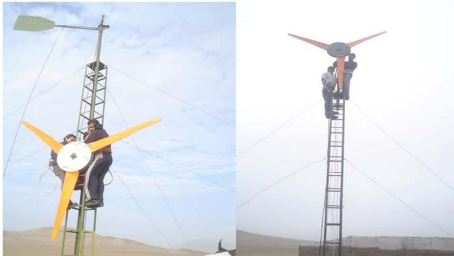
**Figura 5.8.** Izamiento del aerogenerador en campo
