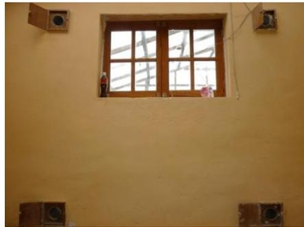
**Figura 25.** Ductos para el intercambio de aire de una habitación con el invernadero.
