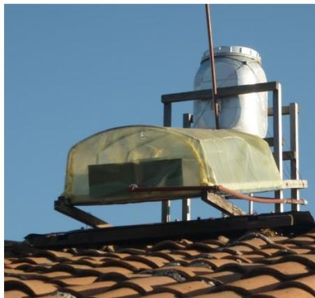
**Figura 26.** Terma solar instalada en el techo.
