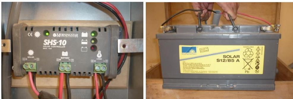
**Figura 27.** Regulador de carga y batería de 12V utilizados en la vivienda 1.
