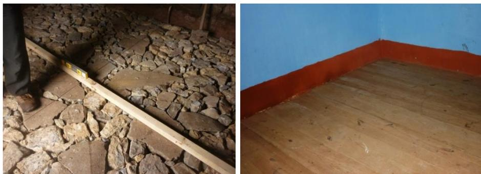
**Figura 21.** (a) Cama de piedra para evitar el ascenso de la humedad y (b) piso entablado con madera de pino machihembrado.
