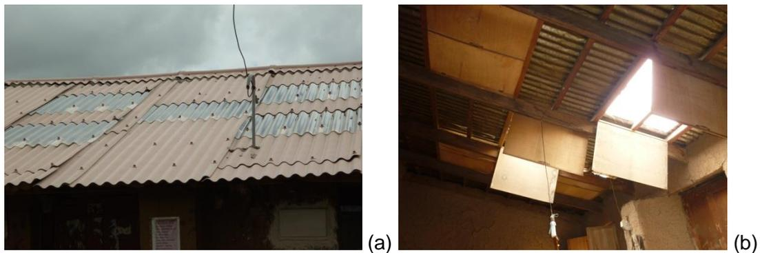
**Figura 30.** Claraboyas en techo de la vivienda 2 (a) vista exterior y (b) vista interior con compuertas de protección nocturna.
