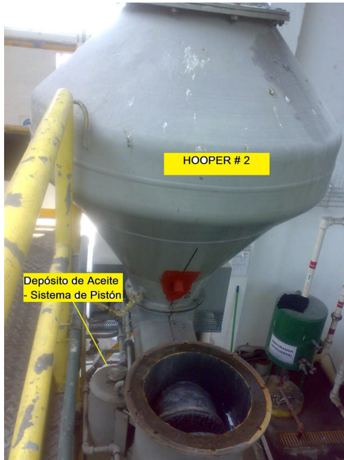
SISTEMA DE ALIMENTACIÓN A GENERADOR DE ACETILENO - HOOPERS
