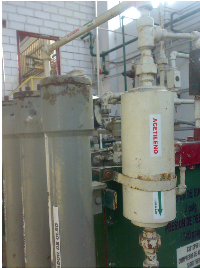
VISTA LATERAL – SECADORES DE ALTA PRESION
