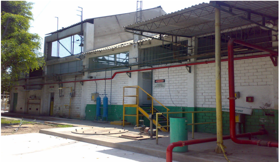
VISTA LATERAL – ACCESO RAMPA DE LLENADO
