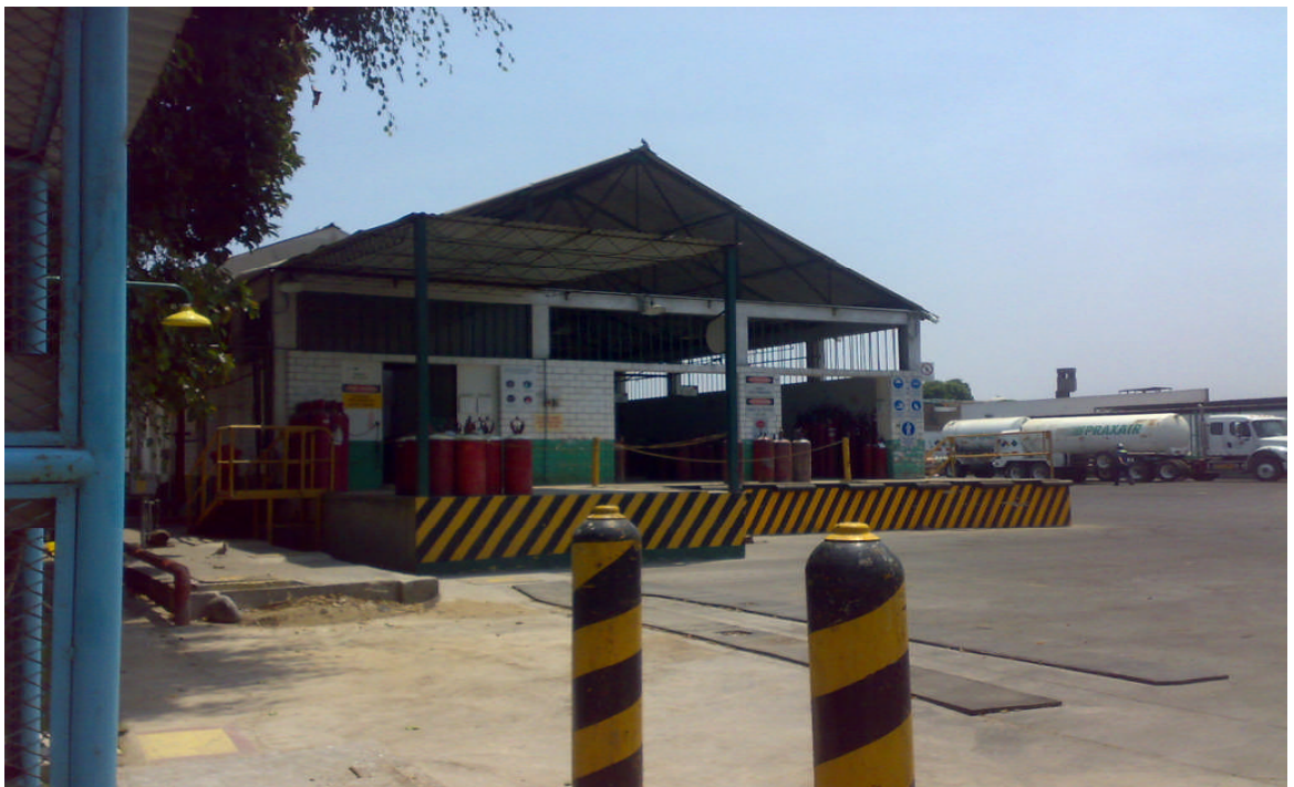
RAMPA DE DESPACHO - PLANTA DE ACETILENO
